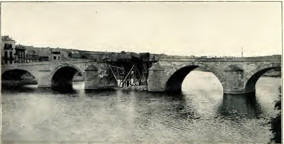
Eine von den Belgiern zerstörte Maasbrücke bei Huy, die von den Truppen nach der Einnahme von Huy in kurzer Zeit derart wiederhergestellt wurde, daß sie die schwersten Transporte trägt. Cop. Vereinigte Fotobureaux, Amsterdam.
