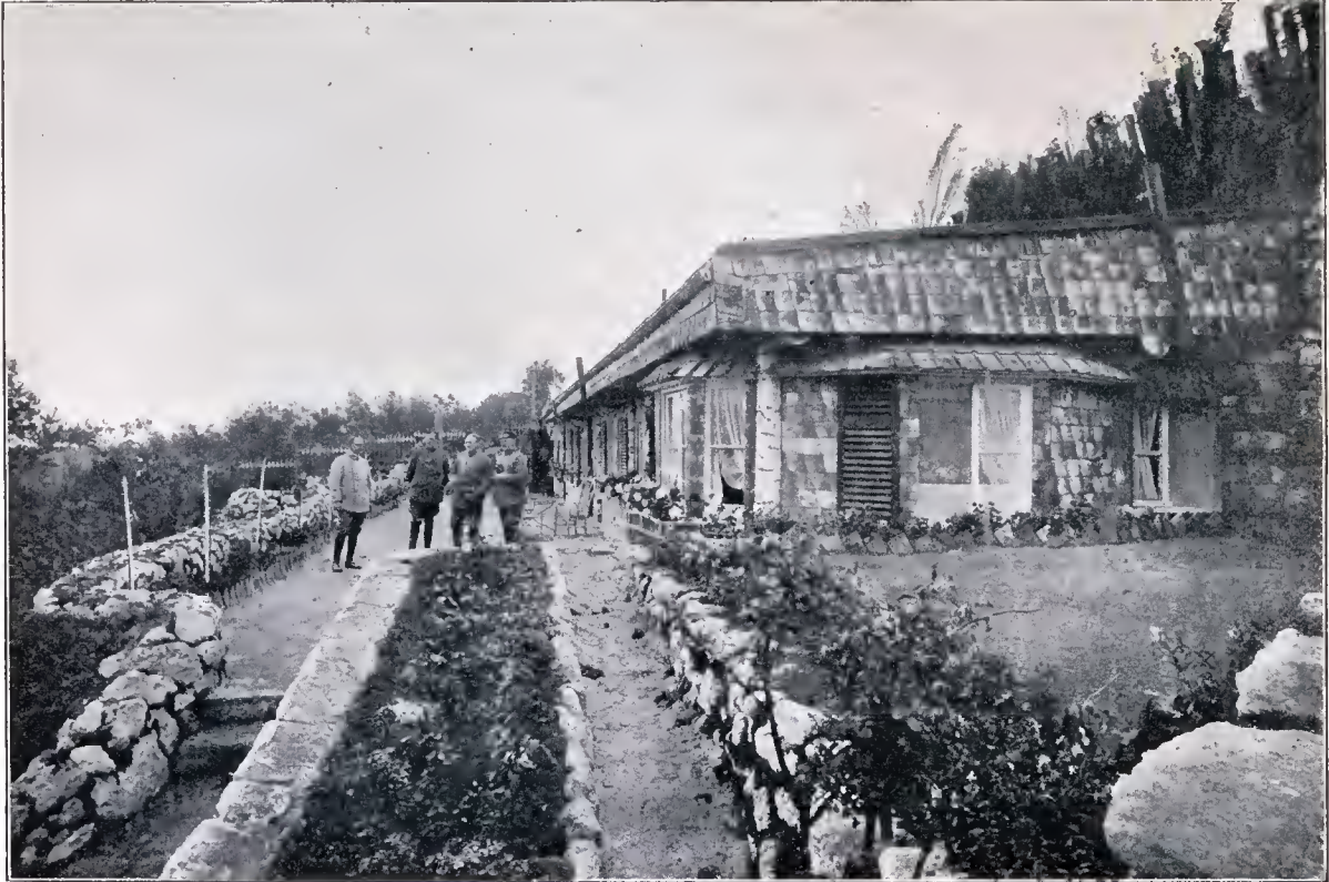
Der Unterstand eines Regimentskommandeurs, errichtet von deutschen Soldaten in Nordfrankreich. Der hübsche Bau dient dem Förderer des Flugwesens, Oberleutnant v. Mercron, und einigen anderen Offizieren als Wohnung. Vor dem Gebäude befinden sich hübsche Anlagen, und an den Fenstern sind Blumenkästen mit blühenden Blumen angebracht. An den Vorgarten schließt sich ein reich mit Gemüse beplanter terrassenförmiger Garten an. Im Rücken des Hauses ist eine starke Barrikade errichtet, das Dach ist ebenfalls gut gedeckt. Fotograf. Oskar Zellmann, Schwiege.
