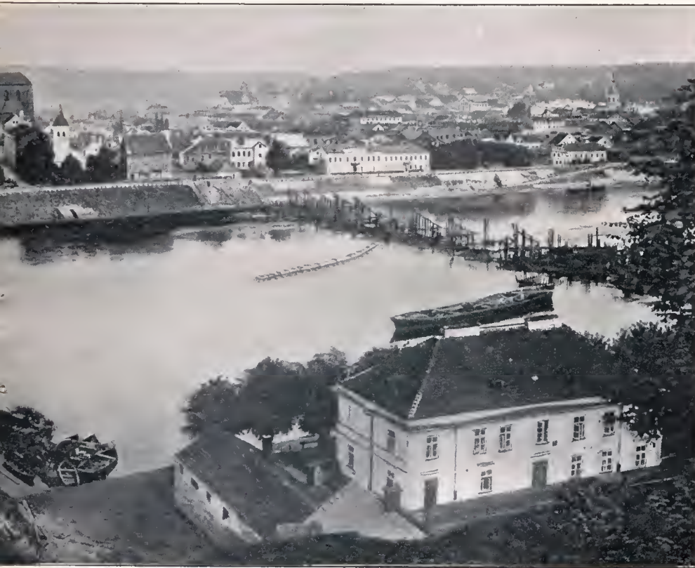
Brücke, rechts die von den Russen niedergebrannte Holzbrücke. Beim Eindringen der deutschen Truppen brannte die Stadt abgebrannt, ist die Stadt bis auf die durchweg zersprungenen Fensterscheiben von der Beschießung nur wenig mitgenommen, Geschütze fast völlig zerstört wurden. (Fot. K. Kühnwind.)
