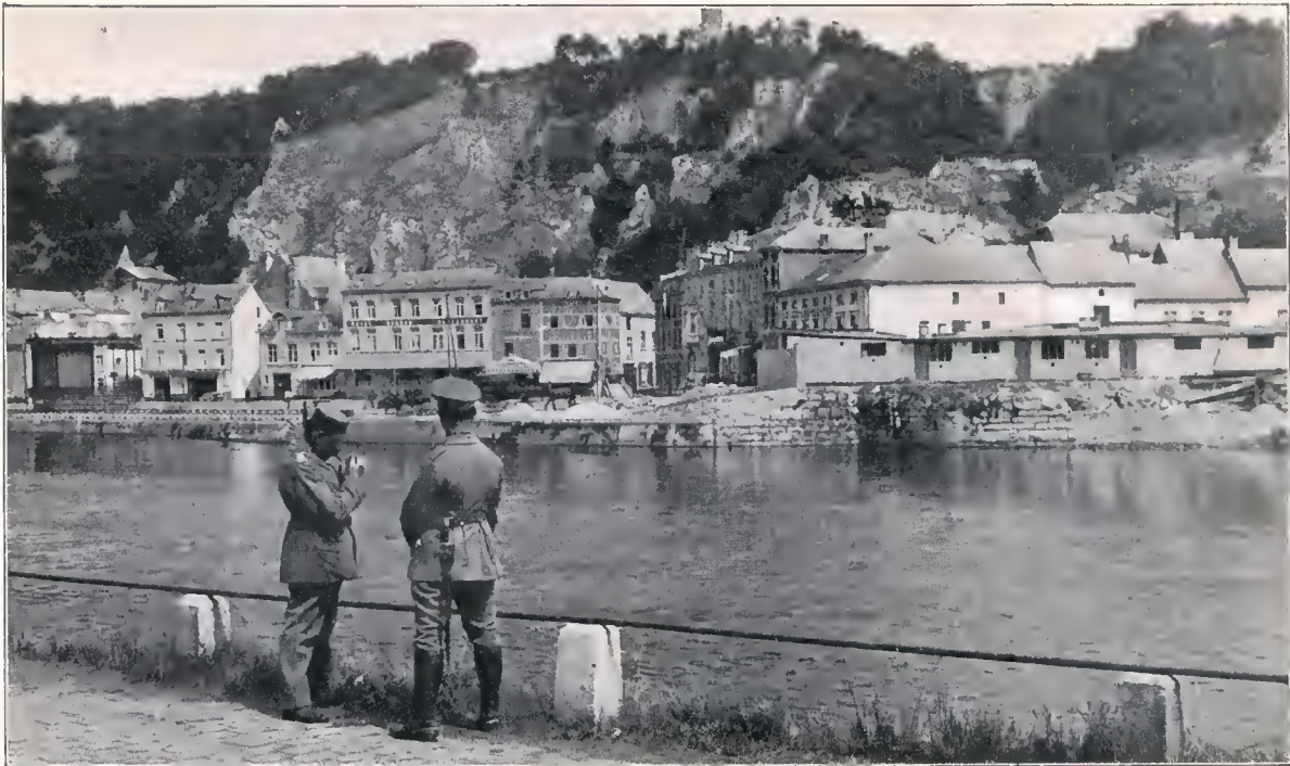
Blick auf den Marktplatz von Dinant mit den neuerbauten Baracken für die Einwohner.
