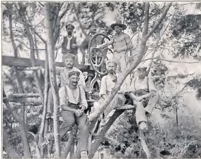
Pumpvorrichtung zum Entwässern und Trockenhalten von Schützengräben.
