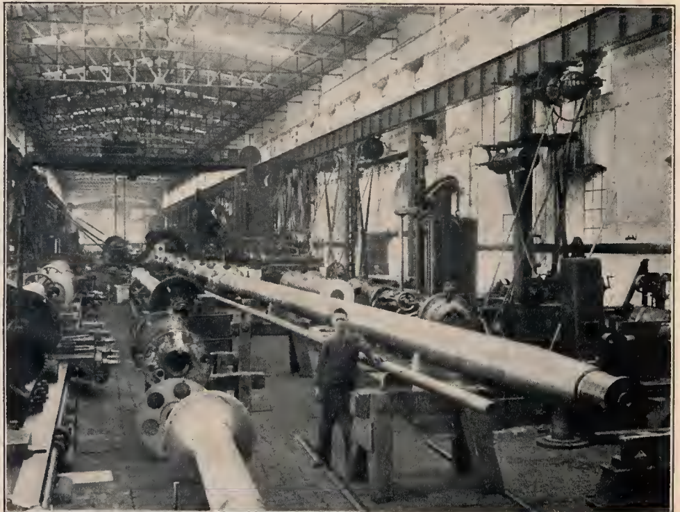
Eine 44,8 Meter lange Welle im Gesamtgewicht von 55000 Kilogramm.
