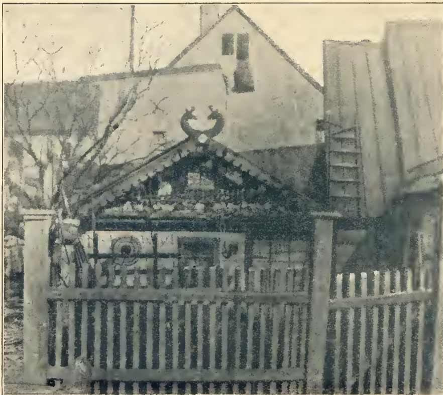
Abb. 5. Der alpine Einschlag im Süden Münchens Almhütte in der Vorstadt.
