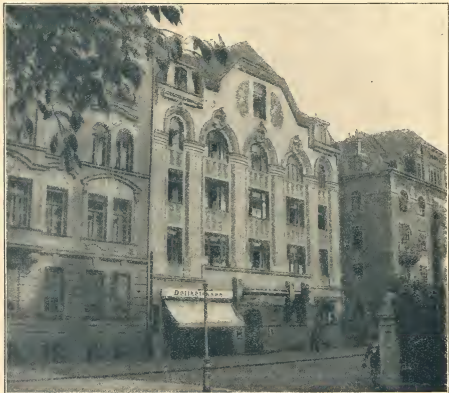
Abb. 7. Haus in Schwabing, als Beispiel des fremden Baustiles im Norden von München.
