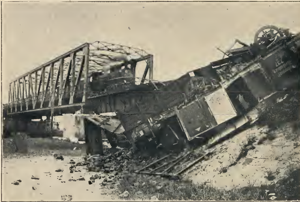
Eisenbahnkatastrophe der Polen in Oberschlesien: Abgestürzte Eisenbahnwagen vor der von den Polen gebrannten Eisenbahnbrücke bei Szarnowanz auf der Strecke Oppeln—Breslau. (Siehe Bilder unten- und nebenstehend.) Phot. Leipziger Freieibüre.
