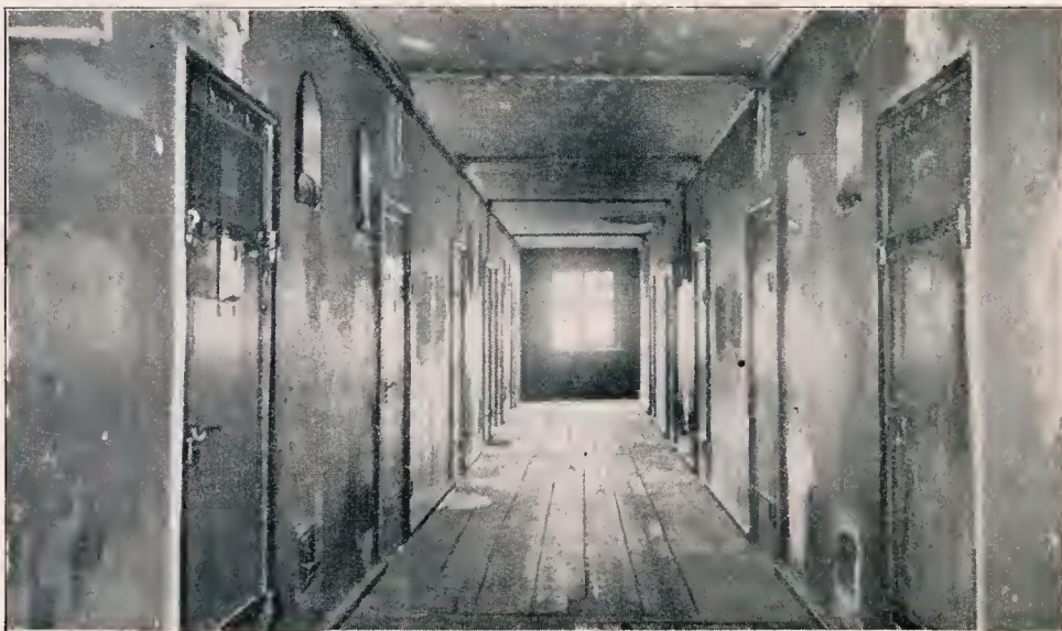
Gefängniszellen als Wohnungen. Um der großen Wohnungsnot zu wehren, greift die Berliner Stadtverwaltung sogar auf die alte, bisher als Gefängnis benutzte Stadtvogtei zurück. Unser Bild zeigt den Korridor des Gebäudes, auf den die Gefängniszellen münden, die nunmehr Wohnzwecken dienstbar gemacht werden sollen.
