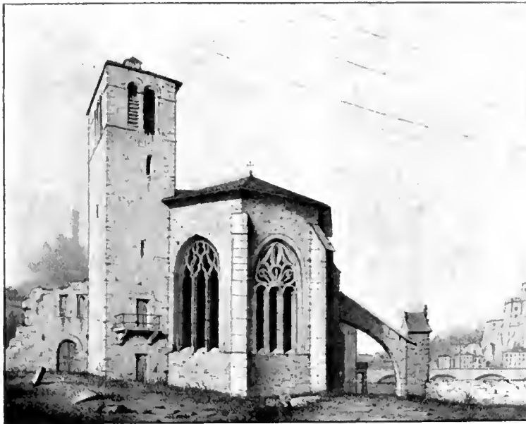
Abside de l'ancienne église de l'Observance.
