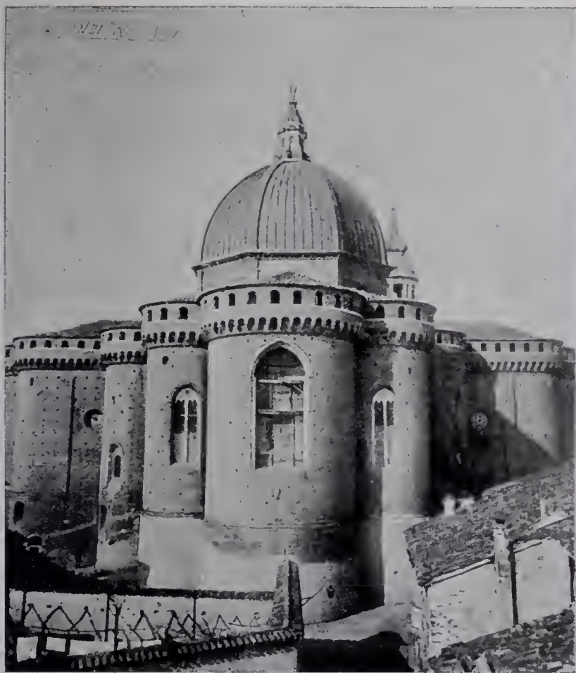
VEDUTA DELLA PARTE POSTICA DOPO IL RESTAURO.
