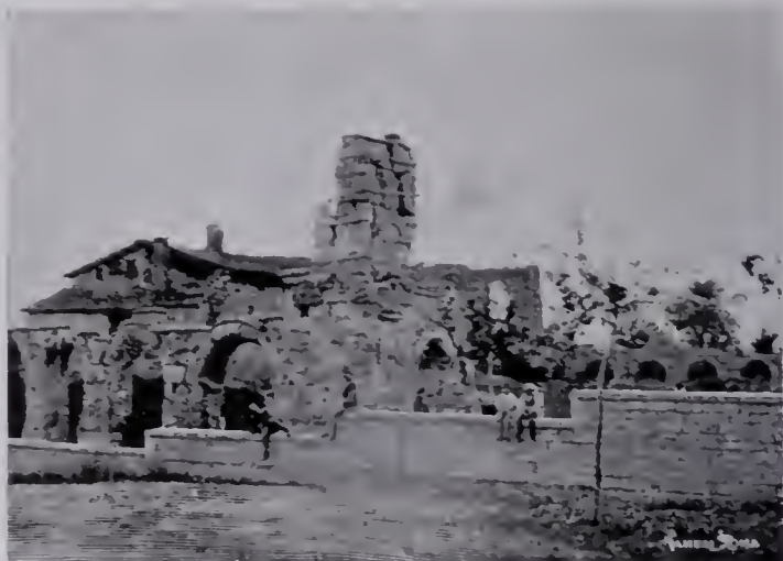
TEATRO PRIMA DELLA DEMOLIZIONE DELLA CASA COLONICA.
