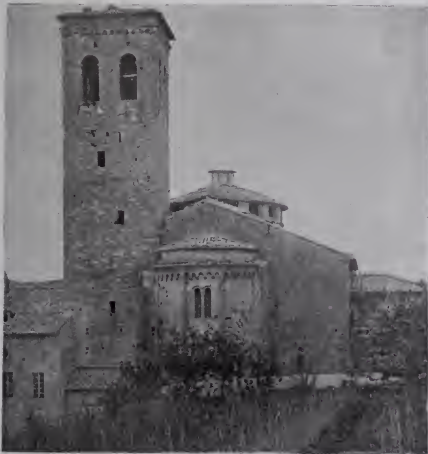
VEDUTA DELL' ABSIDE, DELLA CUPOLA E DEL CAMPANILE.
