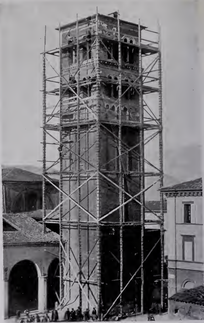
TORRE CAMPANARIA DURANTE IL RESTAURO.
