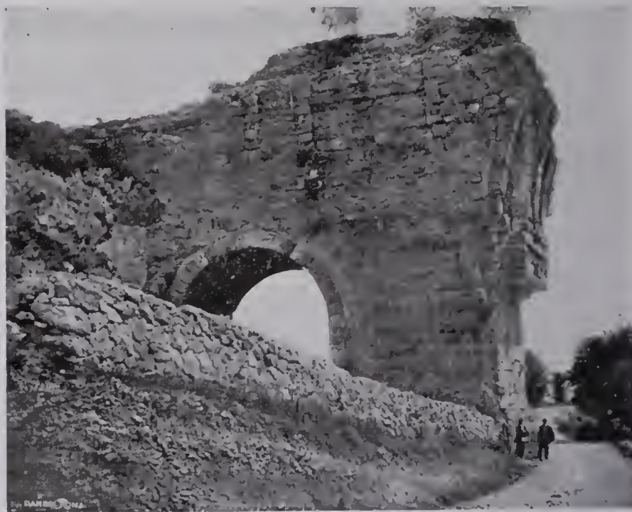
RUDERI DEL PONTE SUL PASSAGGIO DELLA FERROVIA FOLIGNO-ROMA.
