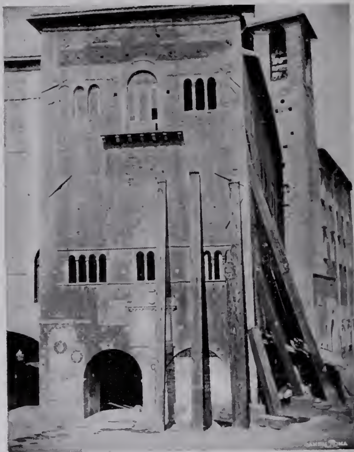
PROSPETTO VERSO PIAZZA VITTORIO EMANUELE II. DOPO LE PUNTELLAZIONI.
