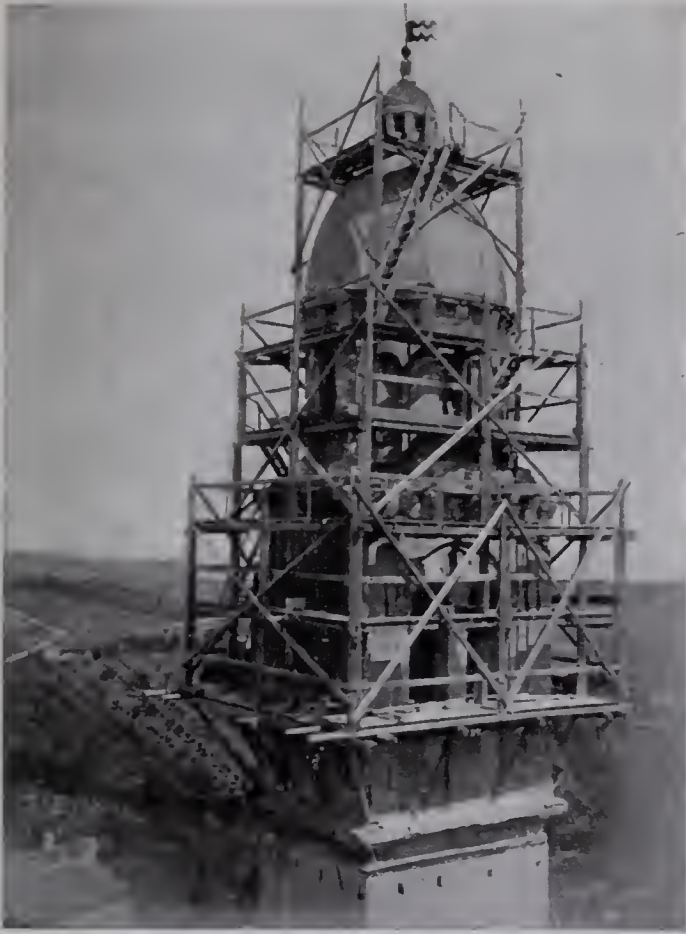
VEDUTA DELL' ARMATURA A POSTO
