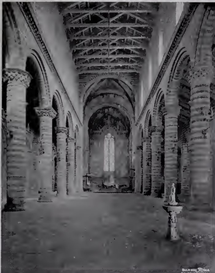
DUOMO DI ORVIETO. VEDUTA DOPO I RESTAURI.
