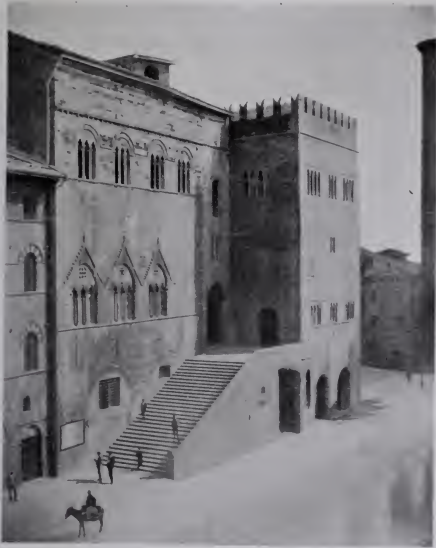
PROSPETTO SULLA PIAZZA VITTORIO EMANUELE DOPO IL RESTAUR.
