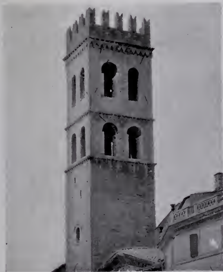
TORRE DOPO IL RESTAURO.
