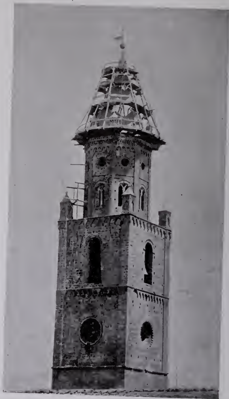
TORRE CAMPANARIA DURANTE I RESTAURI.
