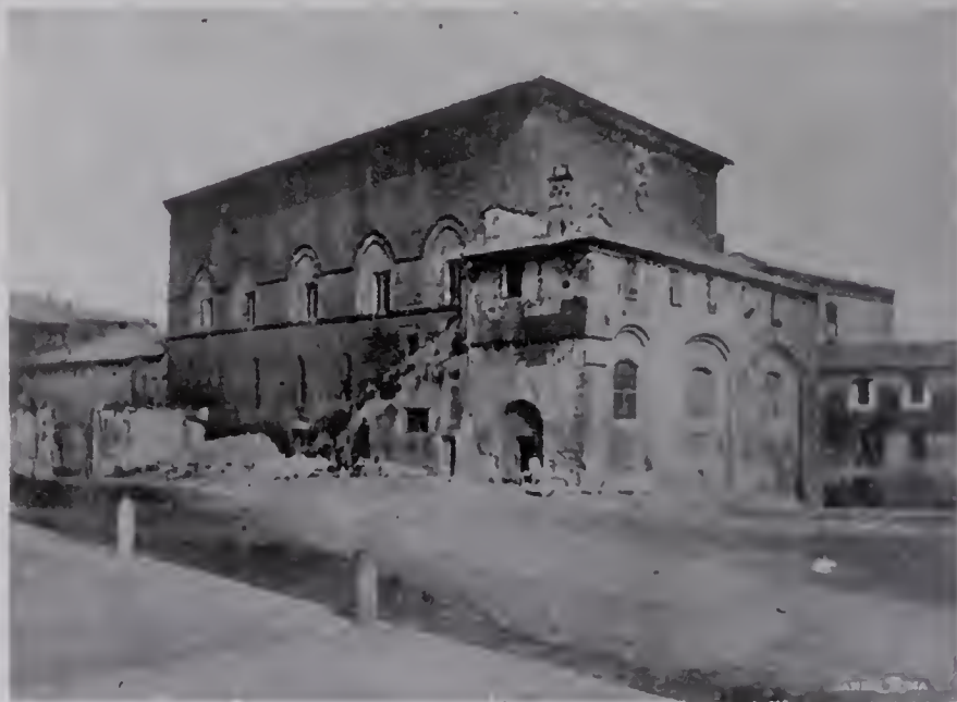
PALAZZO SOLIANO PRIMA DEL RESTAURO.
