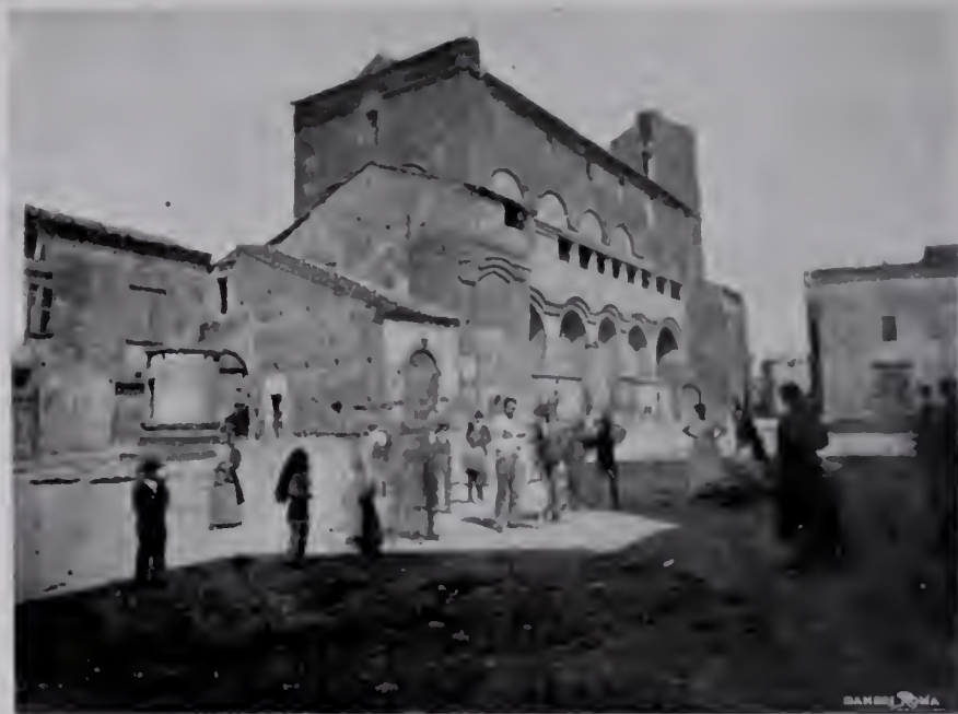
PALAZZO DEL POPOLO PRIMA DEL RESTAURO.
