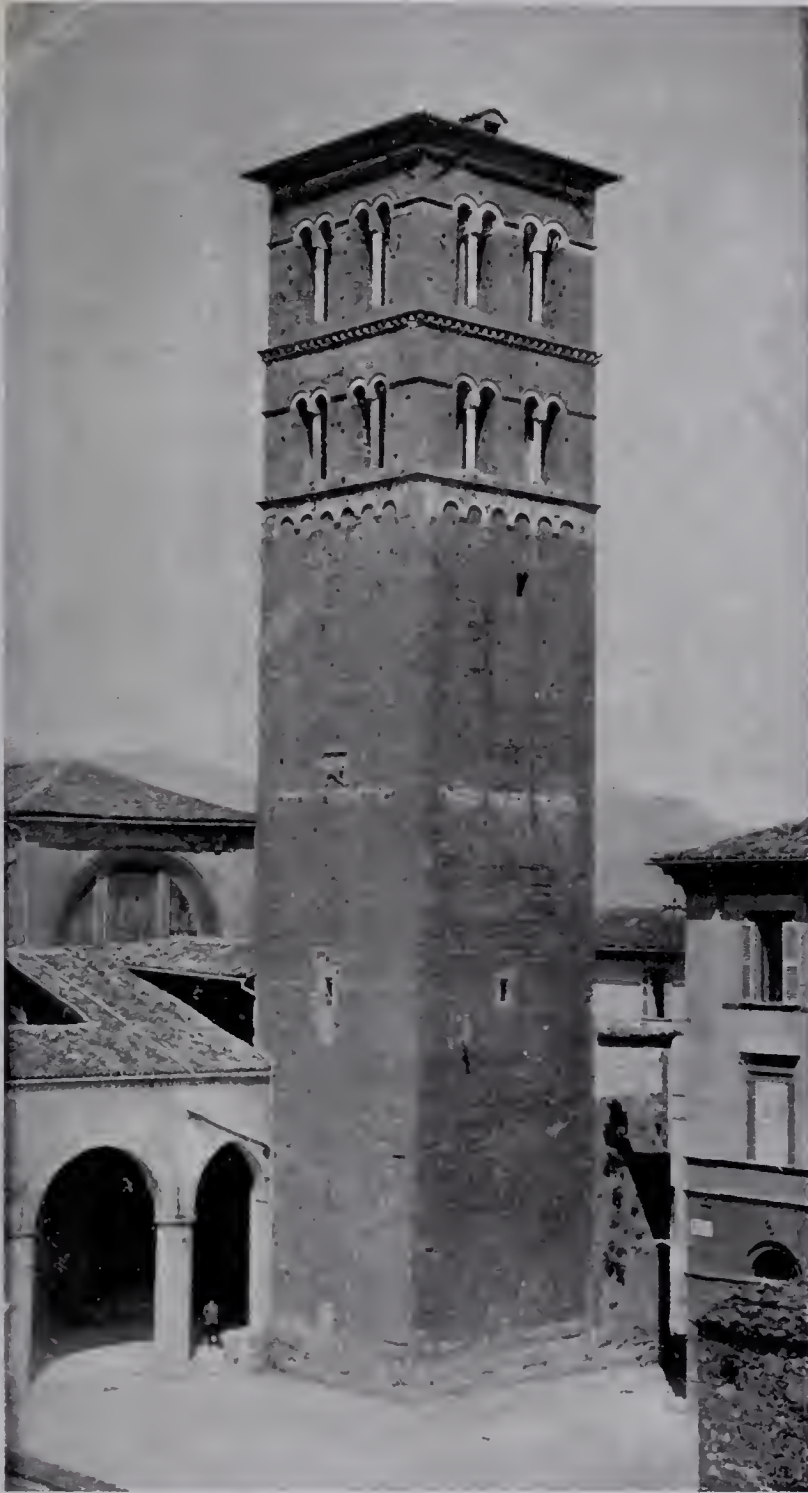
TORRE CAMPANARIA DOPO COMPIUTO IL RESTAURO.
