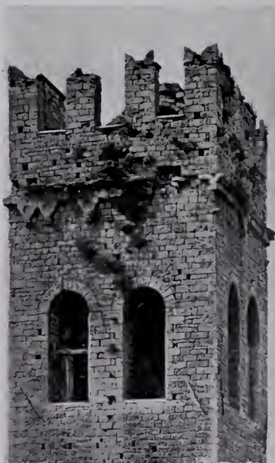
TORRE PRIMA DEL RESTAURO.
