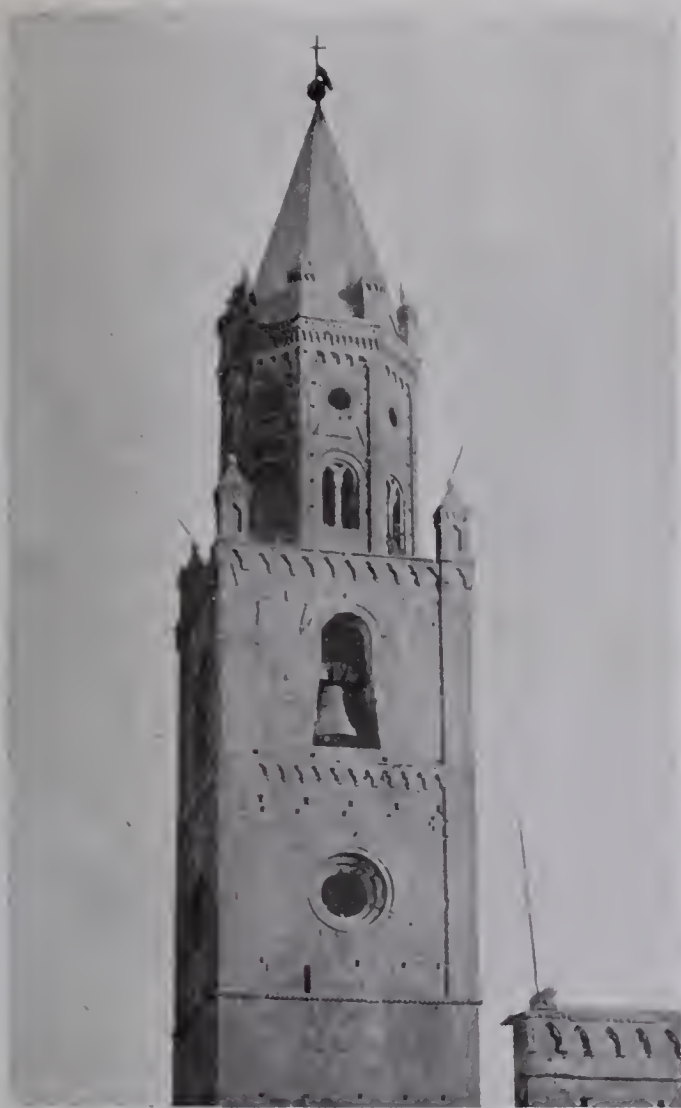
(Fot. dell' Ufficio.) TORRE CAMPANARIA DOPO I RESTAURI.
