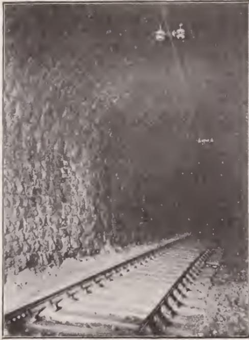
FIG. 22. — Isolement de la ligne de contact dans les tunnels.
