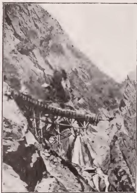
FIG. 13. — Pont provisoire pour la voie de service.
