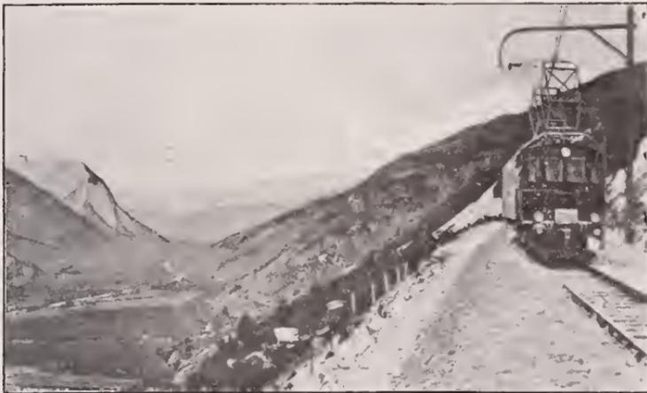
FIG. 19. — Mât-console soutenant le fil en pleine voie.
