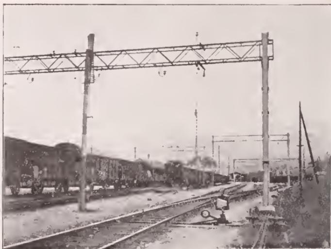
FIG. 21. — Mode de soutènement de la ligne de contact dans les gares.
