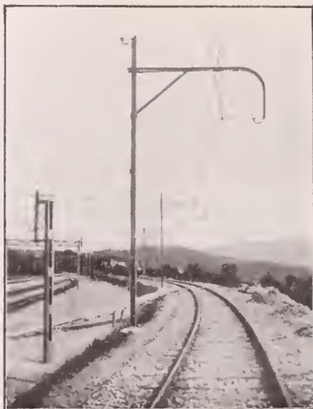
FIG. 20. — Ligne de contact.
