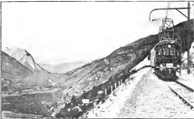
FIG. 19. — Mât-console soutenant le fil en pleine voie.
