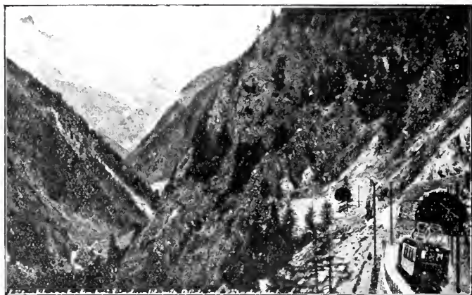
FIG. 4. — Entrée du tunnel de la double boucle.
