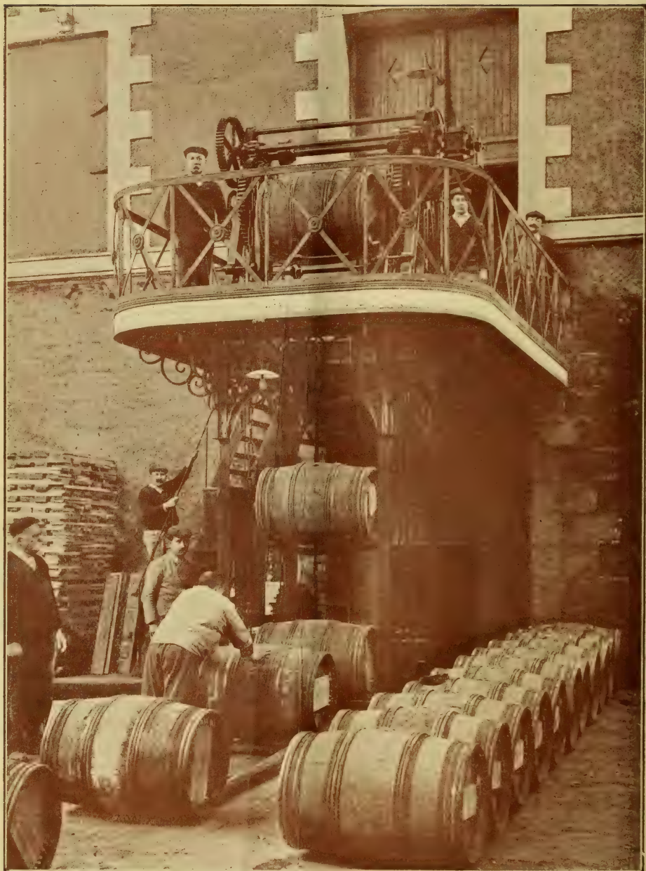
LE MONTE-CHARGES ÉLECTRIQUE DES ÉTABLISSEMENTS CALVET A BORDEAUX
