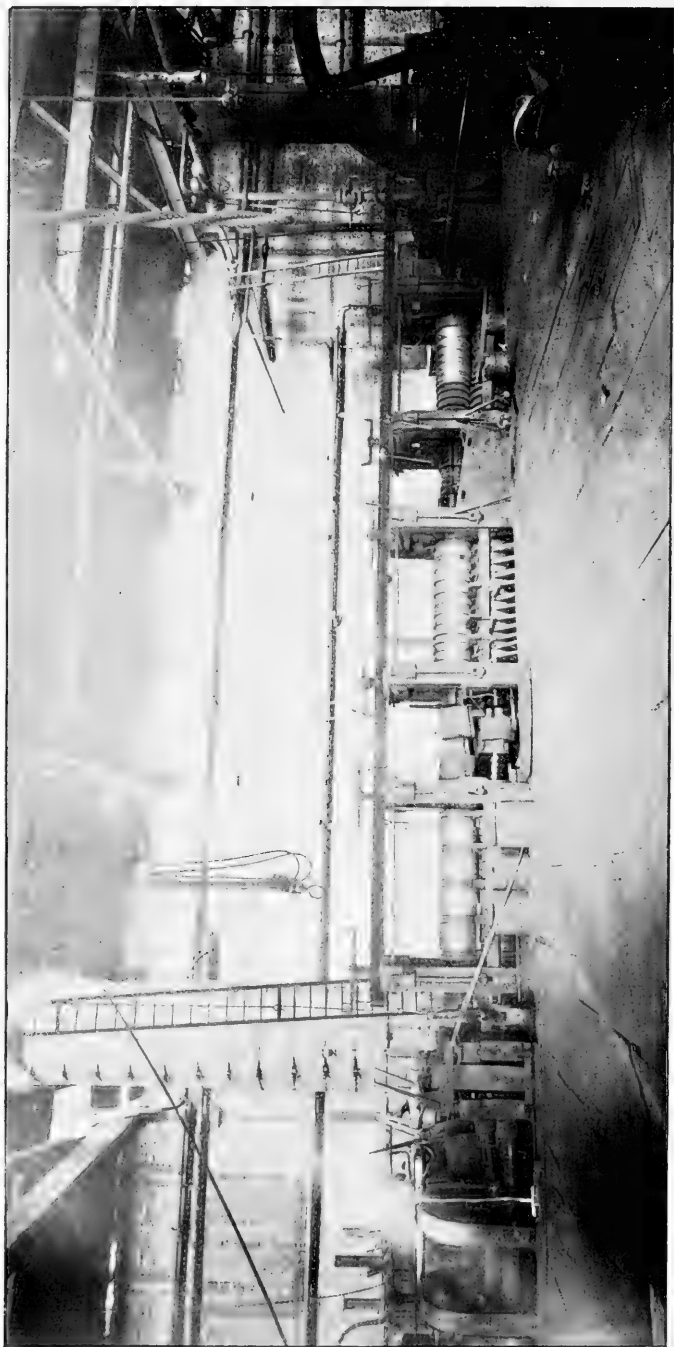
Fig. 1. — Train de puddlage des Acieries de Saint-Chamond. — La loupe de fer sortie du four de puddlage, puis cinglée au pilon pour en éliminer les plus grosses scories et devenue un massain , est transformée en barres par le train de puddlage . Ce train se compose d'une série de trois cages de cylindres montés en chaos , et entre lesquels passent les massains chauds. Les cylindres inférieurs sont mus par la machine à vapeur, visible vers la droite de la figure. Une cage, à gauche de ce dessin, communique le mouvement aux cylindres supérieurs. Passant entre les cylindres de chaque chaos , sous une pression que font varier les vis placées au-dessus de chaque cage, les massains abandonnent les dernières traces d'impuretés qu'ils renfermaient et donnent des barres de fer puddlées . — Derrière l'échelle, on aperçoit une chaudière verticale installée à la suite de l'un des fours à puddler, chaudière qui utilise la chaleur perdue du four.
