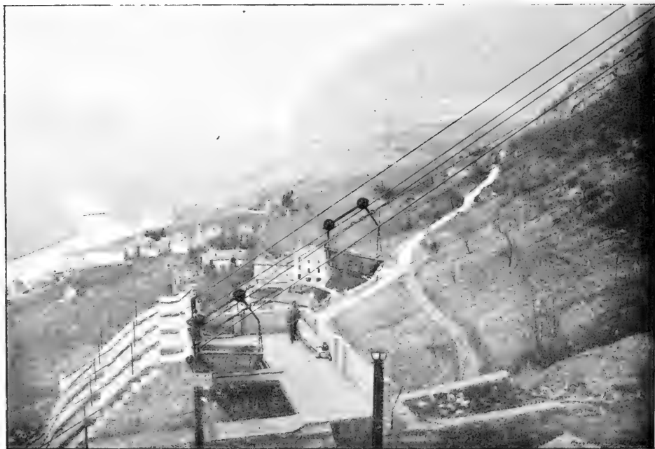
Fig. 17. — Transport des pierres à ciment du Mont Jalla à l'Usine de Ciment de la Porte de France. — Gare d'arrivée.
