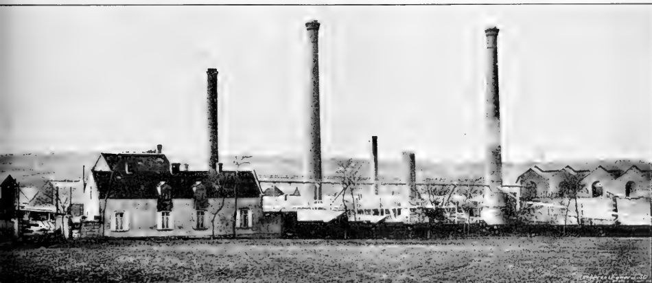
Fig. 14. — Fabrique de ciment Portland de MM. Darsy, Lefebvre et Lavocat à Neufchâtel (Pas-de-Calais).
