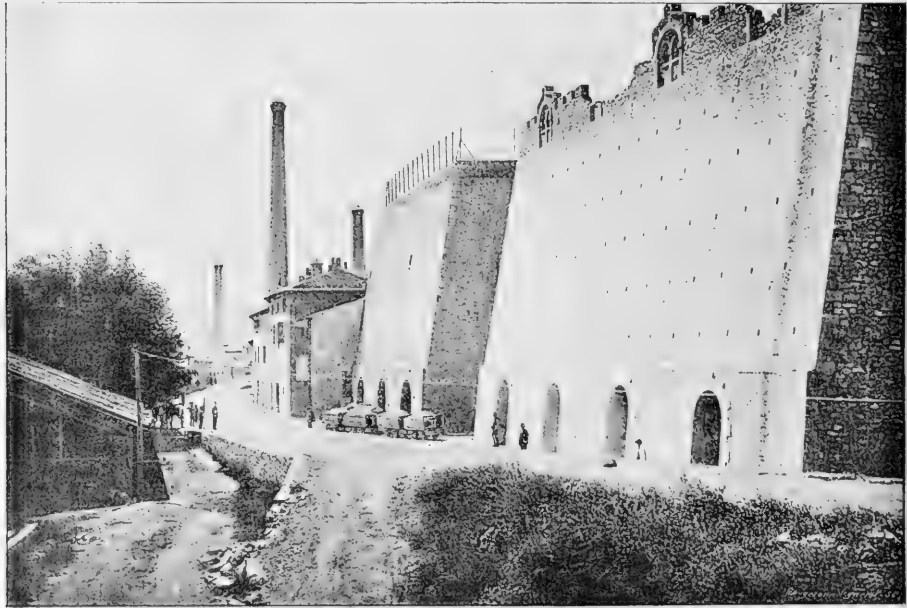
Fig. 2. — Usines de la Société J. et A. Pavin de Lafarge, au Teil (Ardèche). — Massifs des grands fours à chaux de 18 mètres de hauteur. Des wagonnets chargés de chaux cuite sortant des fours se dirigent vers les chambres d'extinction.
