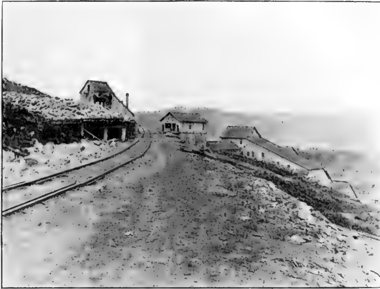
Fig. 3. — Arrivée du minéral à la partie supérieure de l'usine à Cragmont (Ontario).
