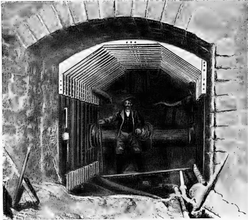
Fig. 11. — Cadres en fer pour résister à la poussée du roc friable.
