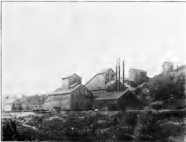
Fig. 4. — Vue générale de l'usine à Cragmont (Ontario). — La roche brute entre à la partie supérieure de l'usine, et le corindon ressort à la partie inférieure sous la forme de produit commercial.
