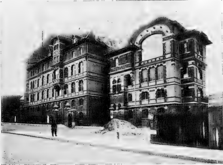
Fig. 7. — Pavillon aseptique et salle d'opérations.
