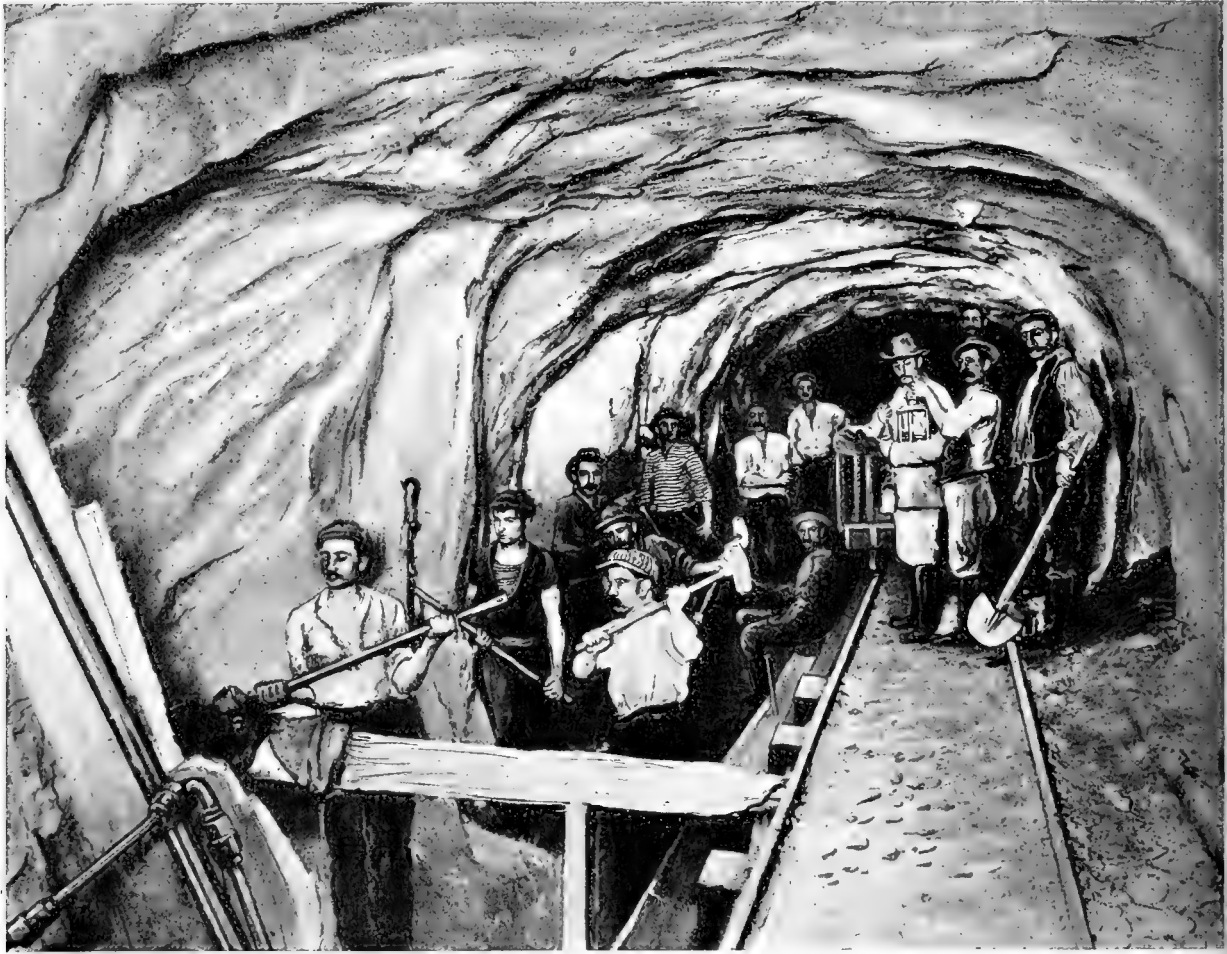
Fig. 1. — Excavation du canal latéral pour l'écoulement des eaux.
