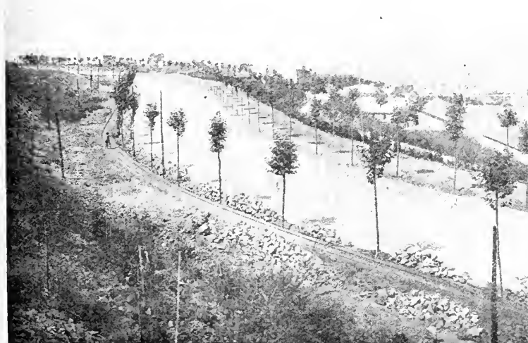
Fig. 40. — Grande Avenue en création.
