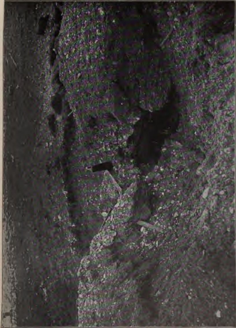
Même coup qu'à la pl. XII mais sur la traverse. Vue de l'entonnoir formé par l'atteinte qui a démoli l'abri. Dimensions de l'entonnoir: 3 m. de long, 3m5 de large, 1m5 de profondeur; volume déplacé environ 4 m 3 (Cf. p. 343).
