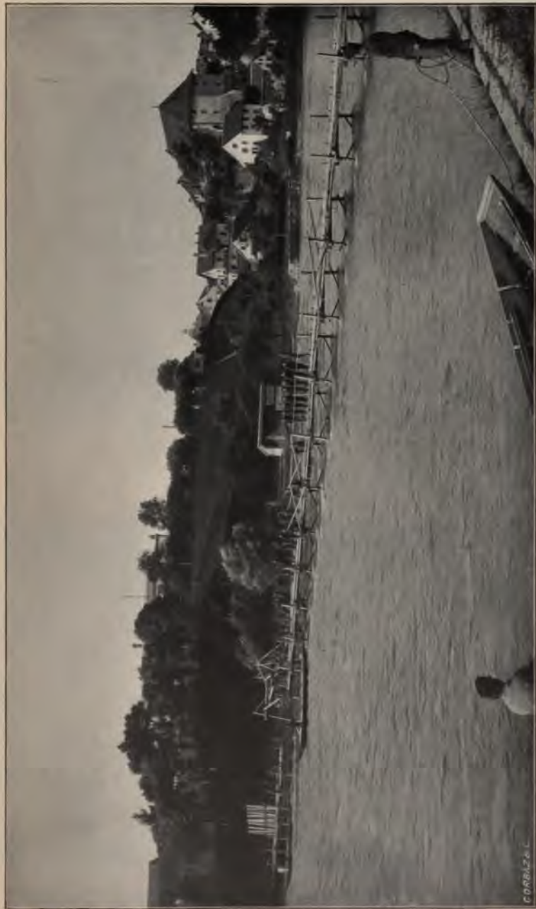
FIG. 1. — La pose d'un chevalet.
