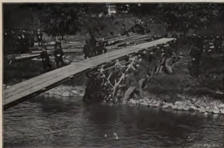
FIG. 3. — Passerelle sur char.
