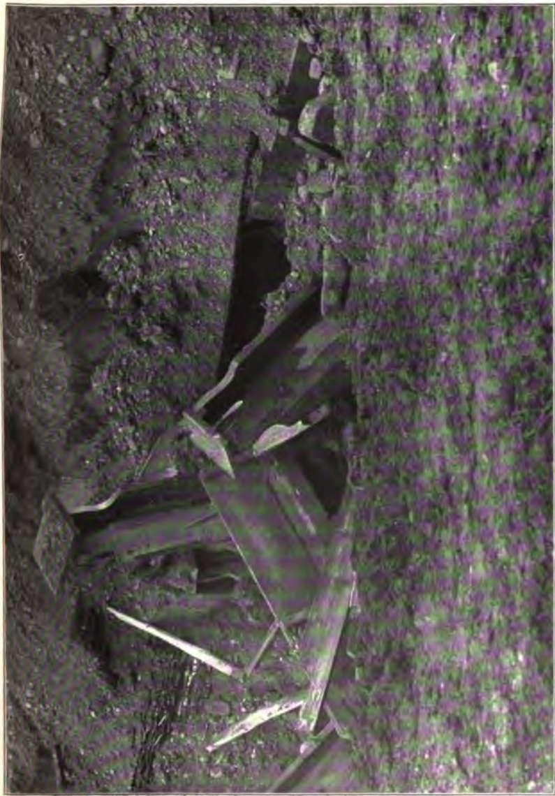
Abri en béton après le bombardement avec obus brisants et obus torpilles (Cf. p. 343).
