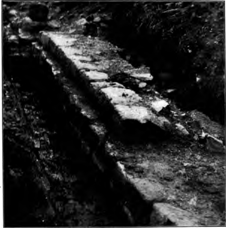
Fig. 10. E. Wall of the Praetorium, looking N.
