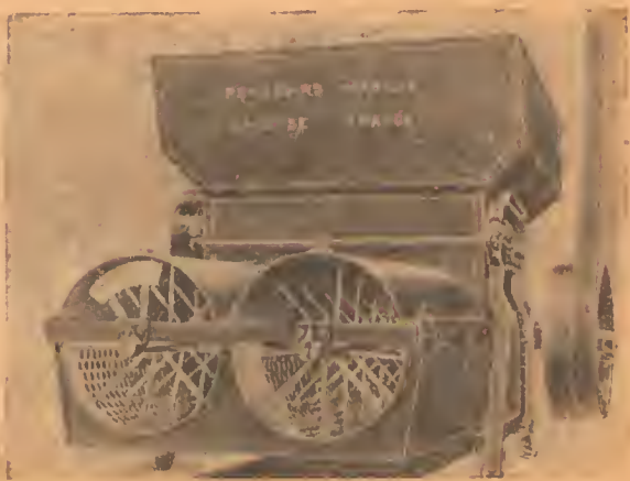
Рис. 15. Двухвальная гребнеотделительная машина Мабилля.
