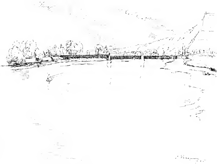
BARRAGE AND LOCKS, PORT-VILLEZ.
