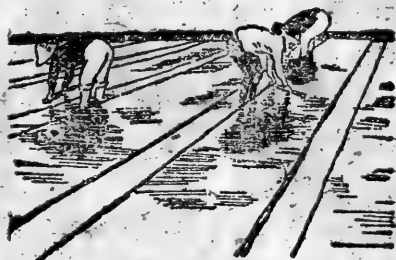
⑫床面的整理 整个床面，必须保持水平。
