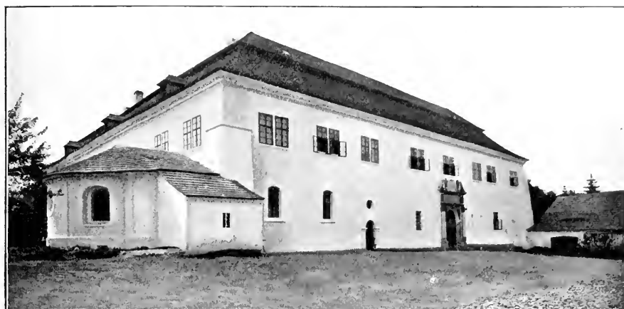
Obr. 87. Dolní Studenec. Východní pračelí zámku.
