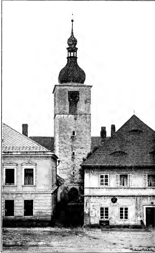
Obr. 82. Příbyslav. Věž u kostela. Pohled z náměstí.
