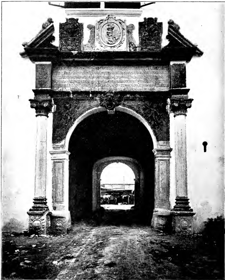
Obr. 88. Dolní Studenec. Portál do zámku.
