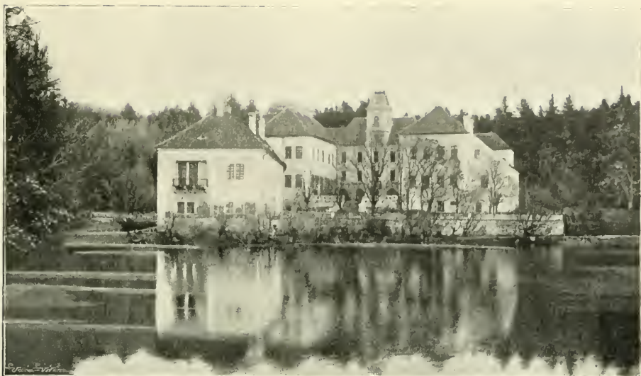
Obr. 93. Žinkovy. Pohled na zámek před opravou.
