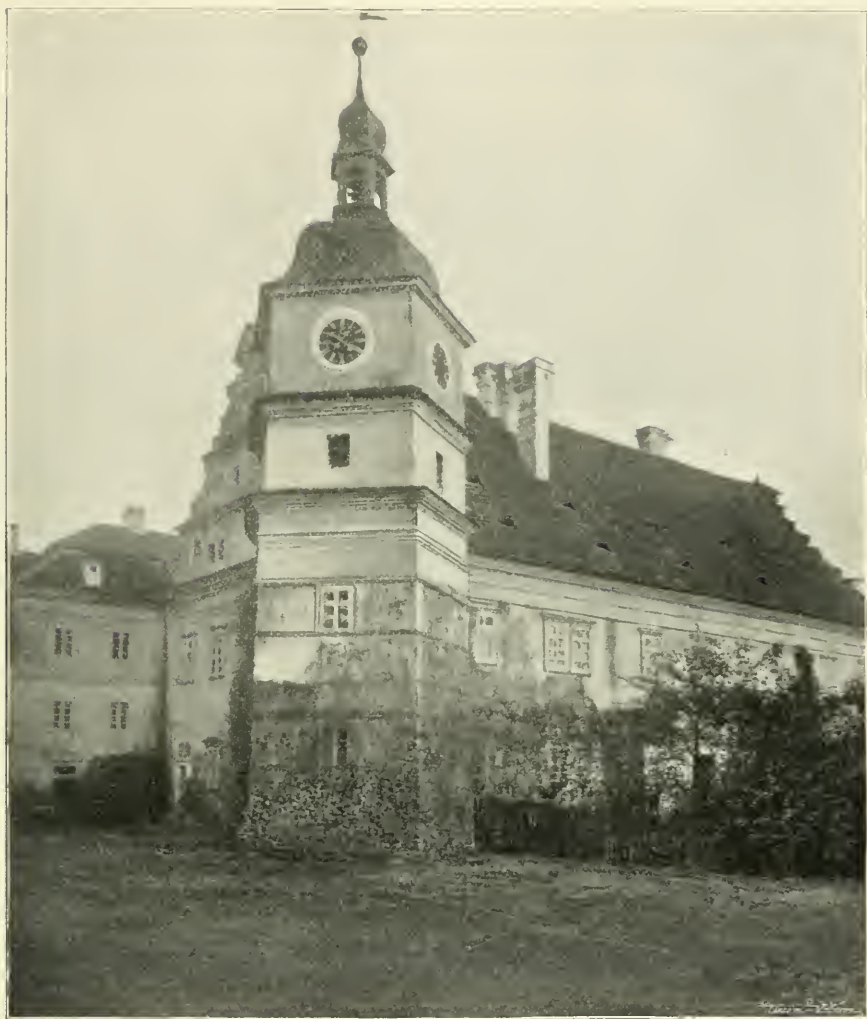
Obr. 48. Červené Poříčí. Nároží zámku s věží.
