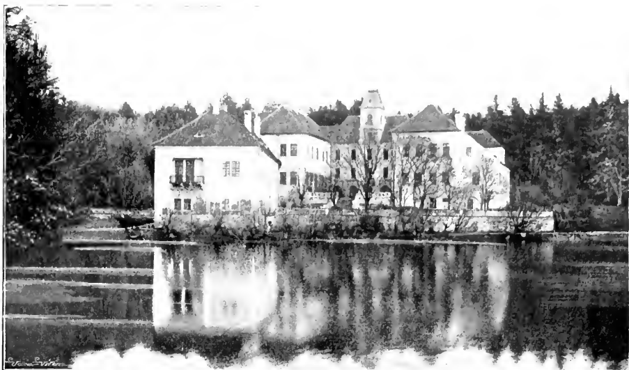
Obr. 93. Zinkovy. Pohled na zámek před opravou.
