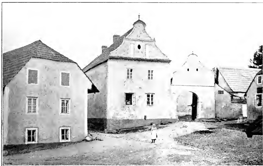
Obr. 40. Nepomuk. Pručelí domu čp. 85.
