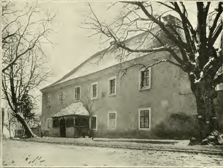
Obr. 101. Toskánka. Pohled od silnice.
