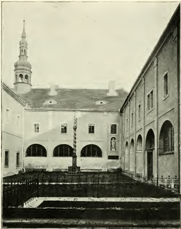
Obr. 28. Hájek. Pohled do nádvoří klášterního od západu.
