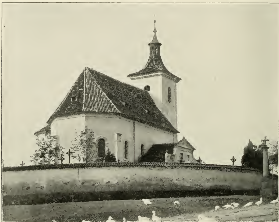
Obr. 88. Svárov. Kostel sv. Lukáše. Pohled od severovýchodu. V pravo sloup ze XVII. století.
