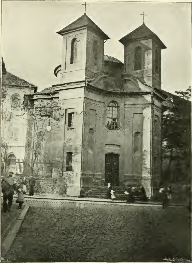
Obr. 60. Kladno. Kaple sv. Floriána. Pohled od jihu.
