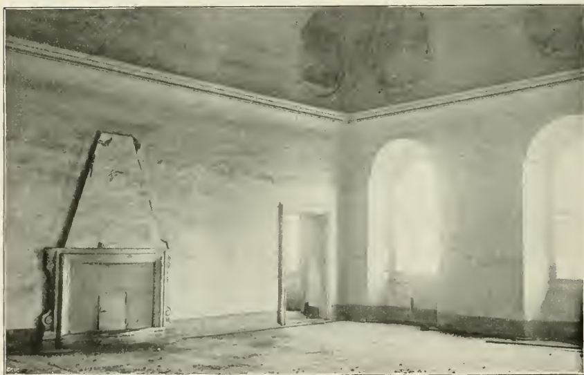
Obr. 10. Buštěhrad. Zámek. Pohled do sálu v 1. patře.
