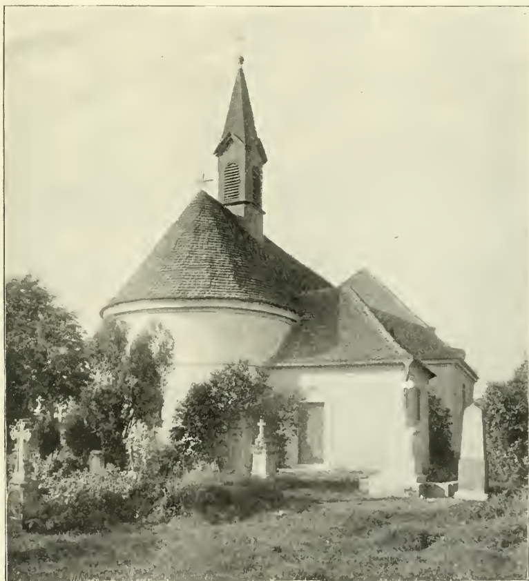
Obr. 83. Rapice. Kostel sv. Mikuláše. Pohled od východu.
