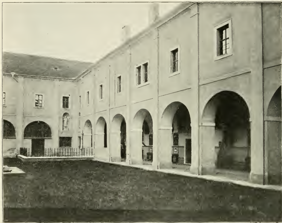
Obr. 29. Hájek. Pohled do klášterního nádvoří od severu.
