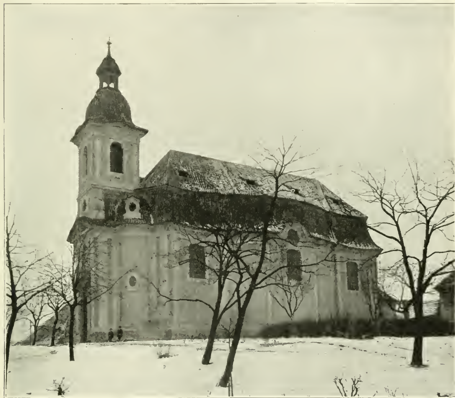
Obr. 30. Hořelice. Kostel sv. Jana Křt. Pohled od jihu.
