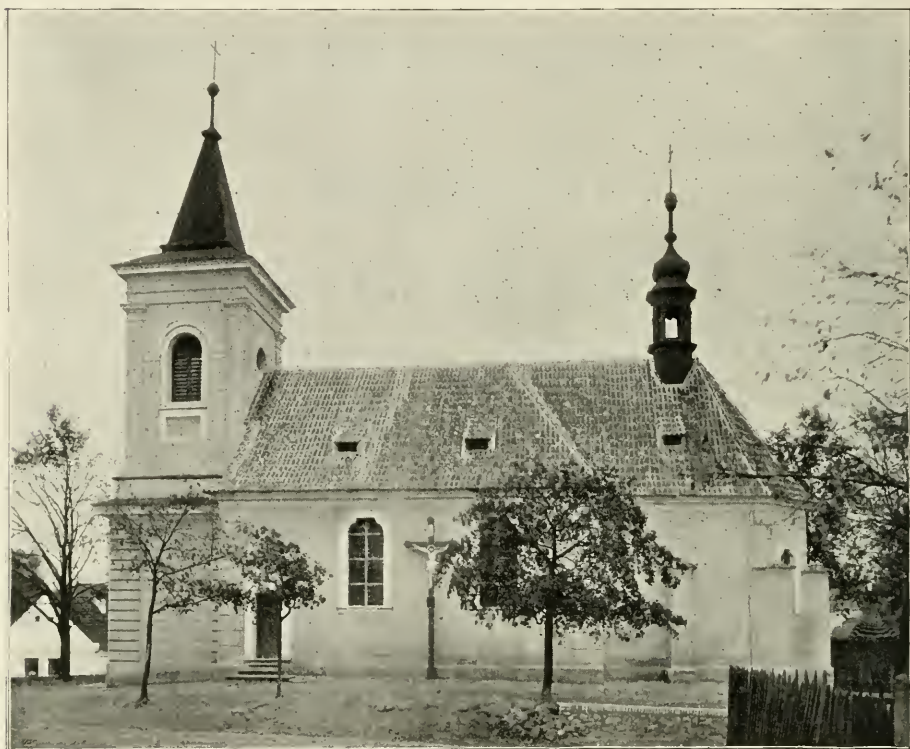
Obr. 46. Chýňava, Kostel sv. Prokopa. Pohled od jihu.
