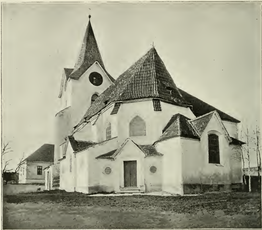
Obr. 41. Hostivice. Kostel sv. Jakuba. Pohled od jihovýchodu.
