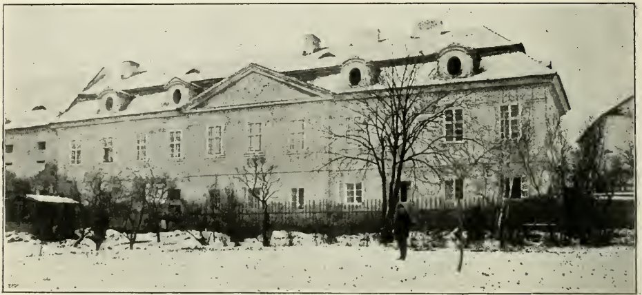
Obr. 34. Hořelice. Zámek. Pohled na zahradní průčelí.
