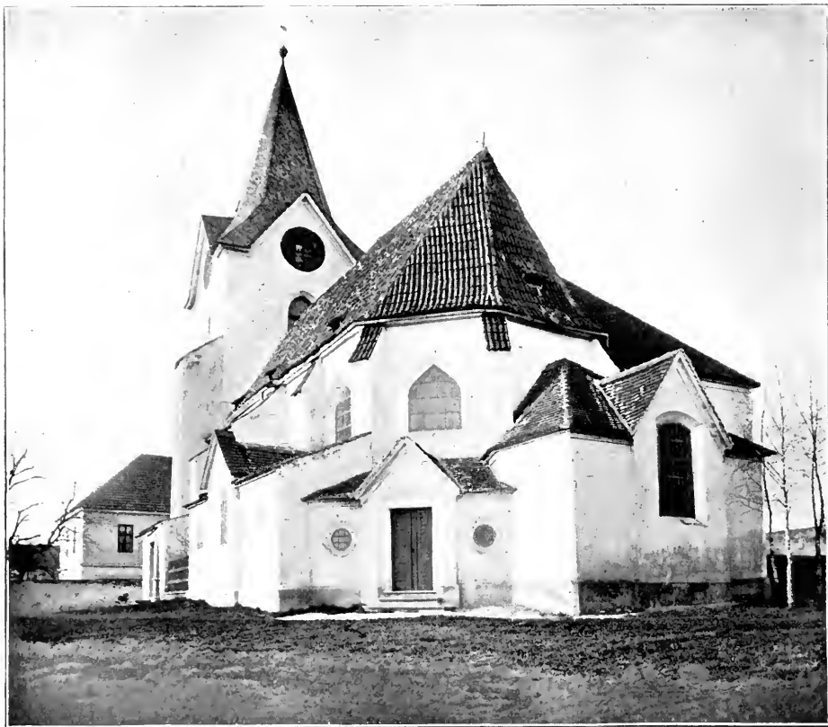
Obr. 41. Hostivice. Kostel sv. Jakuba. Pohled od jihovýchodu.
