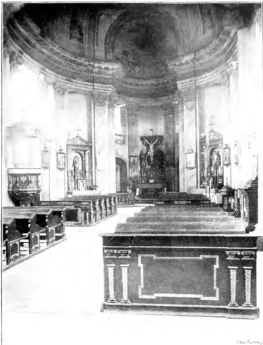
Obr. 11. Buštěhrad. Zámek. Pohled do kaple sv. Trojice.
