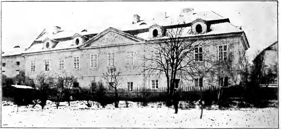
Obr. 34. Hořelice. Zámek. Pohled na zahradní průčelí.
