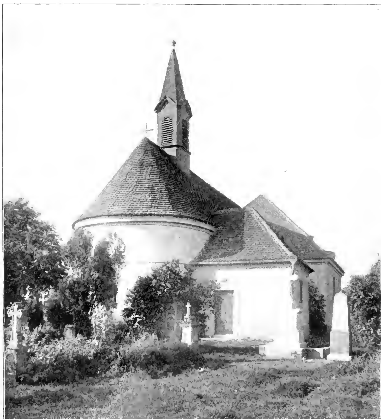
Obr. 83. Rapice. Kostel sv. Mikuláše. Pohled od východu.
