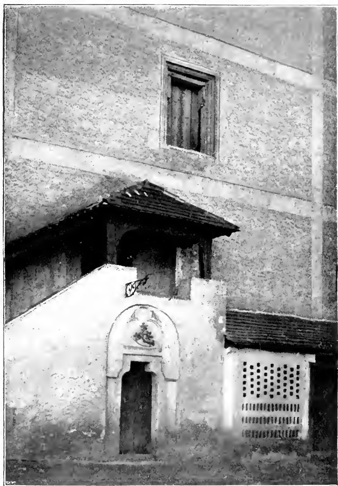
Obr. 76. Litovice. Tvrz. Pohled na schodiště a portálek do sklepa.
