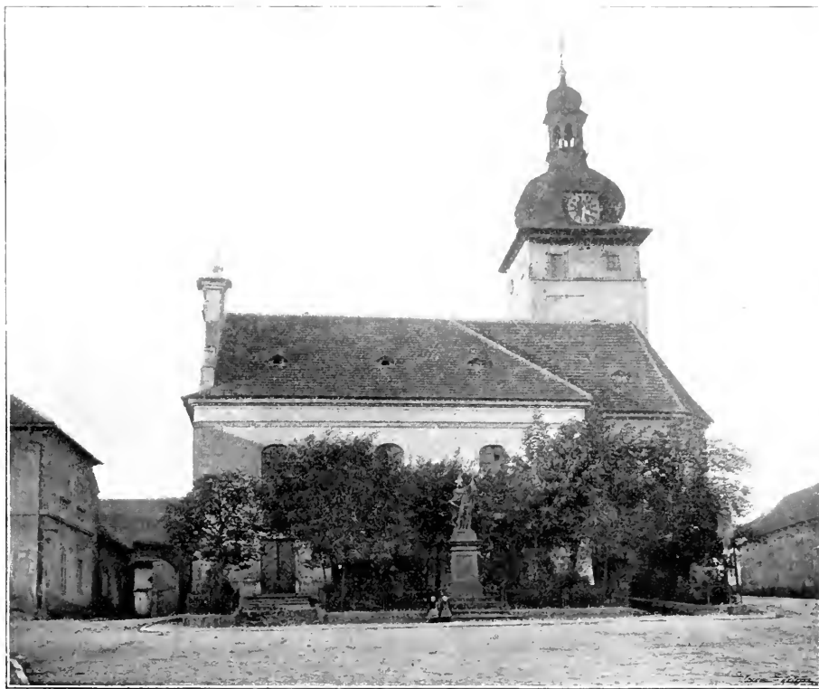
Obr. 105. Úhošť. Kostel sv. Petra a Pavla. Pohled z náměstí.
