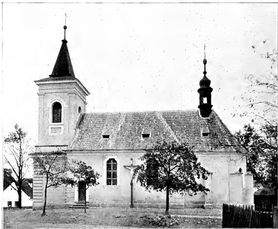
Obr. 46. Chýňava. Kostel sv. Prokopa. Pohled od jihu.
