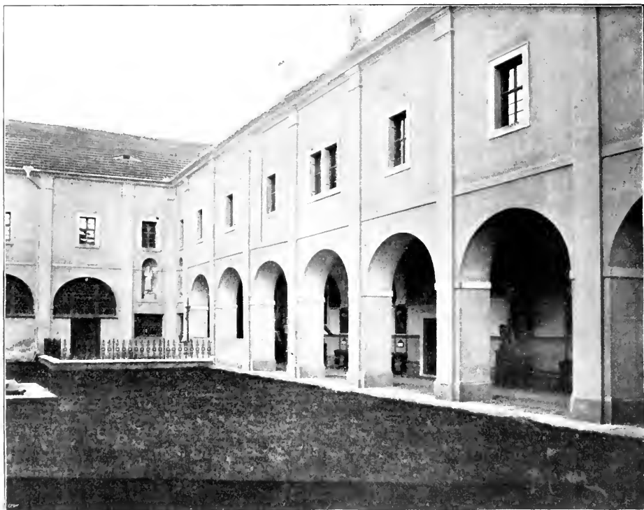
Obr. 29. Hájek. Pohled do klášterního nádvoří od severu.
