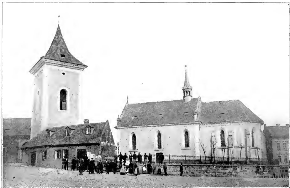
Obr. 51. Kladno, Kostel P. Marie. Pohled od jihovýchodu. (Stav před zbrořením r. 1897.)
