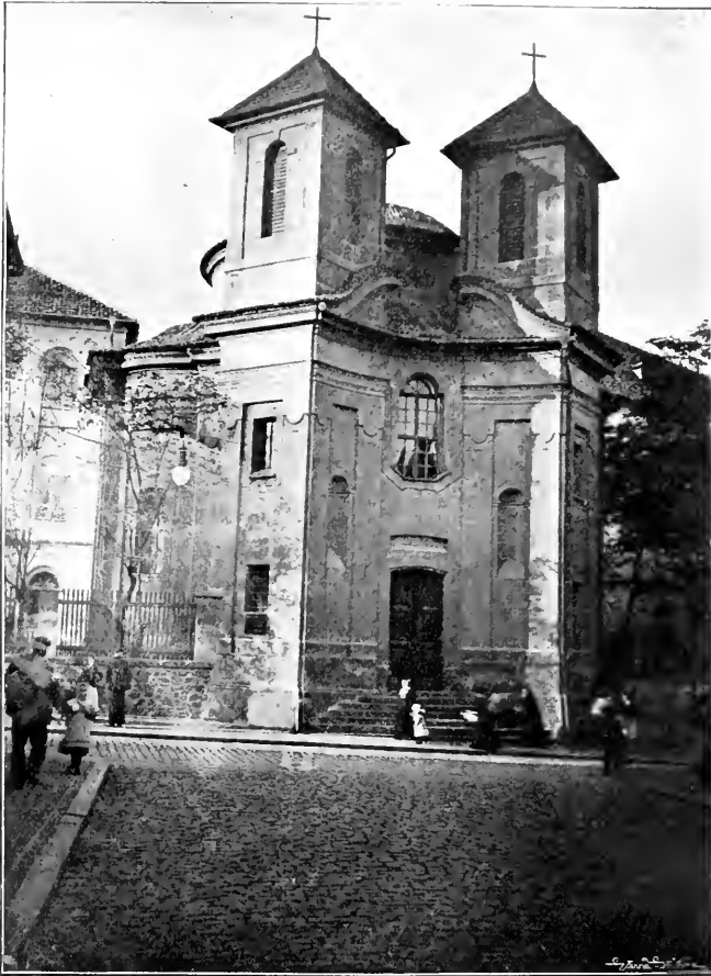
Obr. 60. Kladno. Kaple sv. Floriána. Pohled od jihu.
