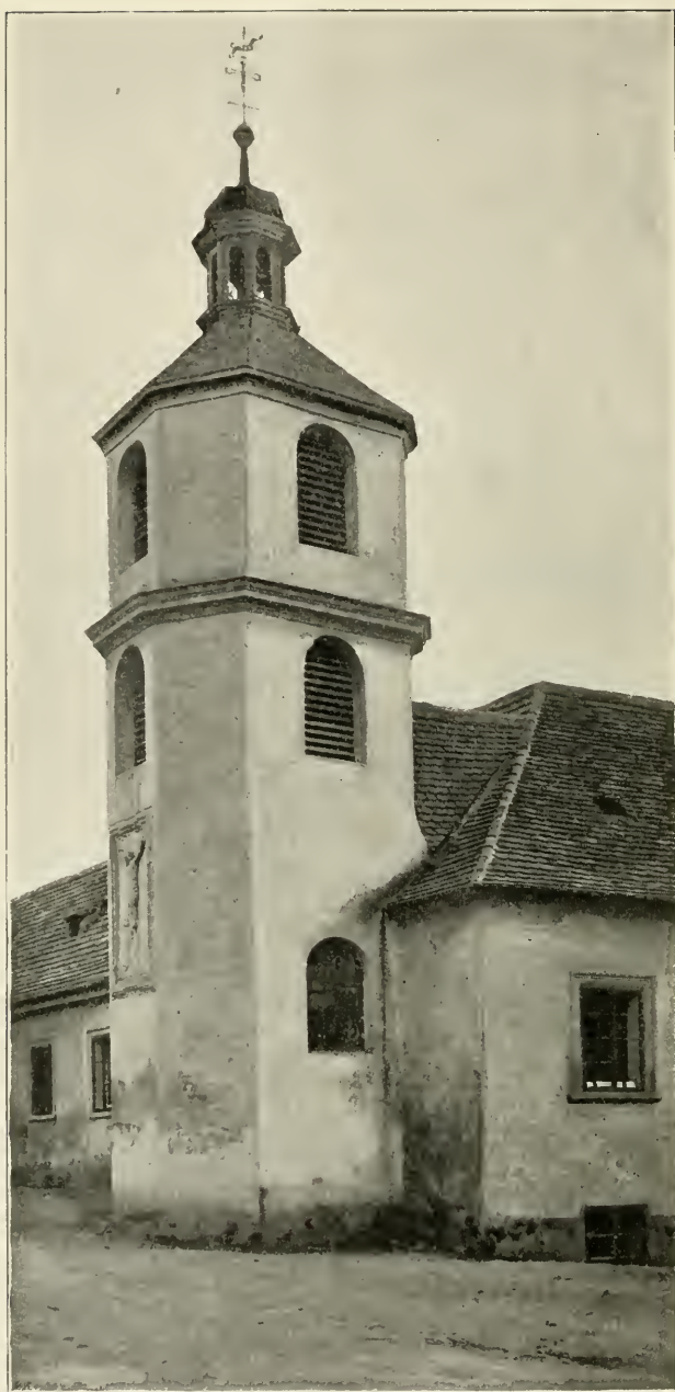
Obr. 1. Bráník. Bývalá zámecká kaple.
