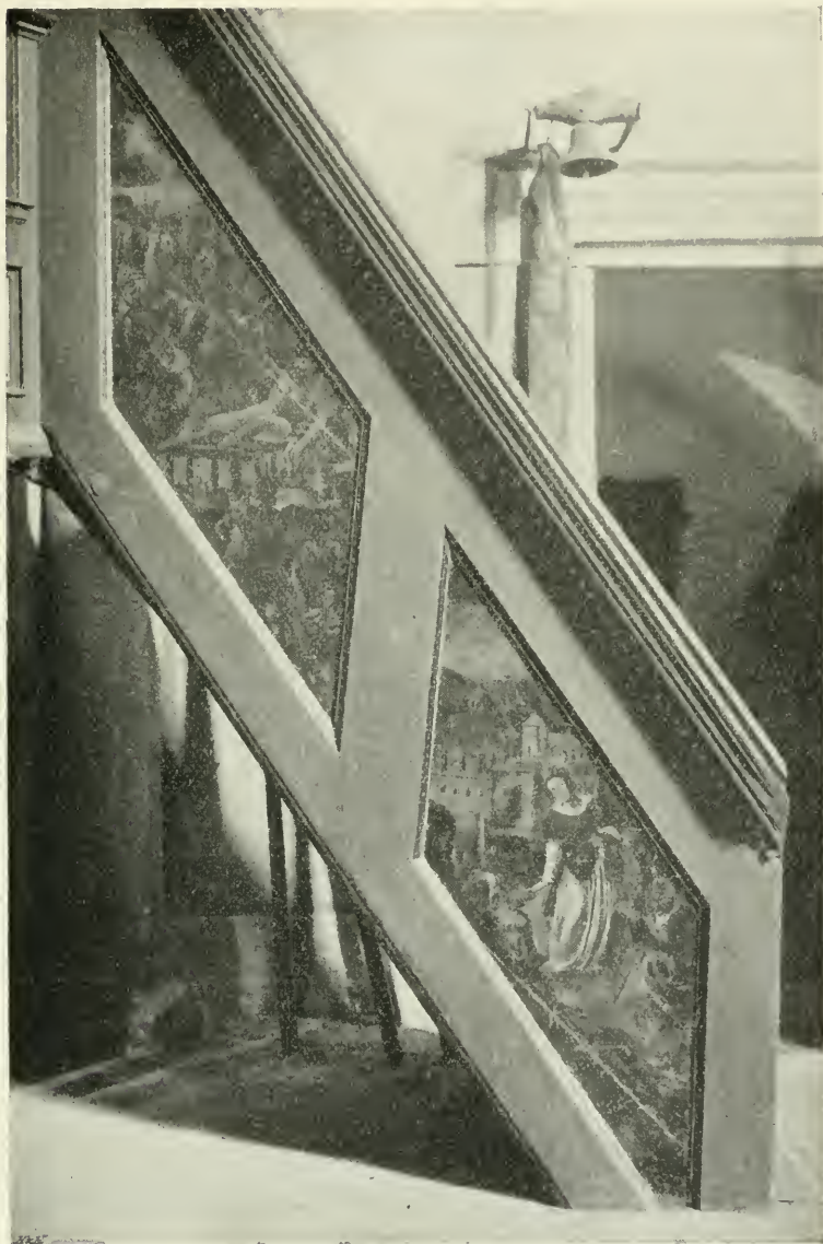
Obr. 128. Libeň. Malby na schodišti kazatelny.
