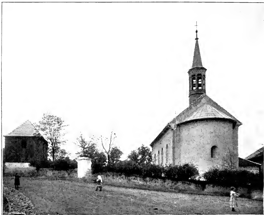
Obr. 16. Hostivař. Pohled na kostel.
