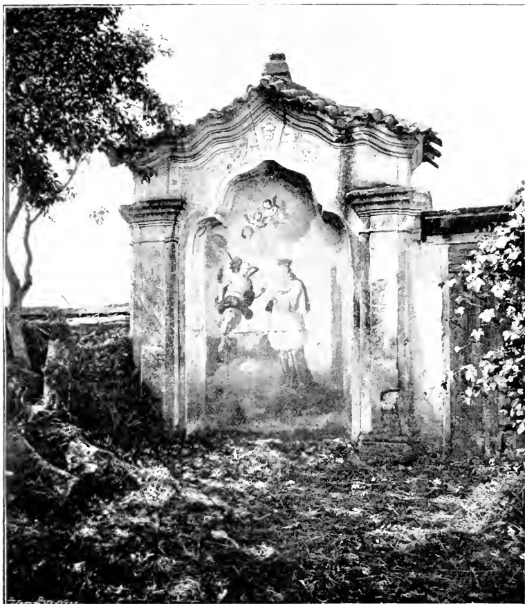
Obr. 28. Hradištko. Kaplice ve zdi zahradní s obrazem sv. Norberta
