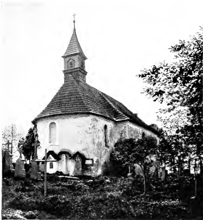
Obr. 58. Jilové. Hřbitovní kostelík.
