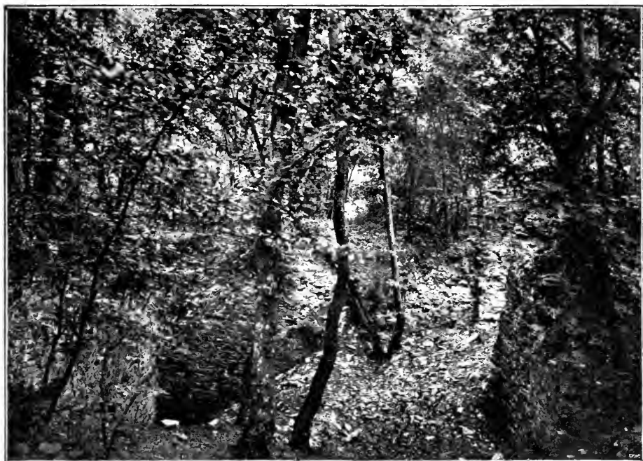
Obr. 115. Kunratice. Pohled na zbytky zdiwa hradního paláce se strany jihozápadní
