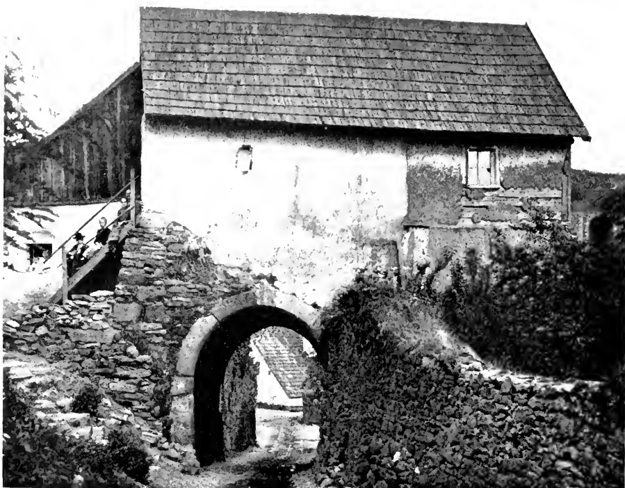
Obr. 127. Stříbro. Koubkova branka. Pohled vnitřní.
