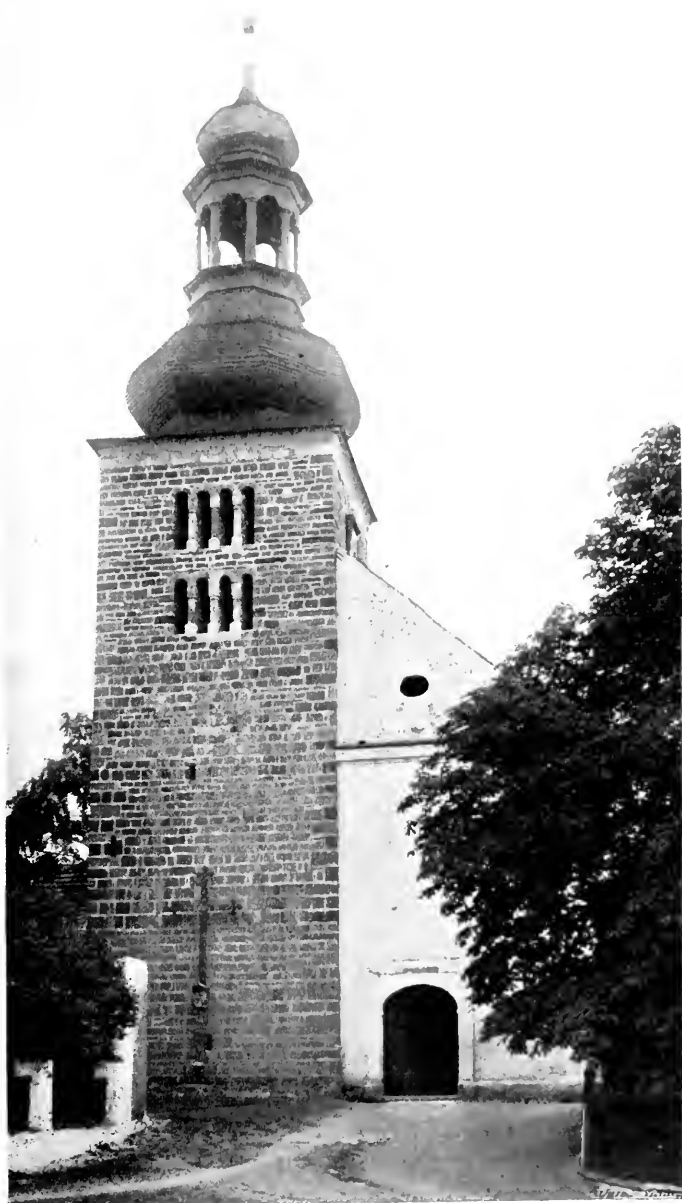
Obr. 198. Svojsín. Kostel sv. Petra a Pavla. Pohled na západní průčelí.
