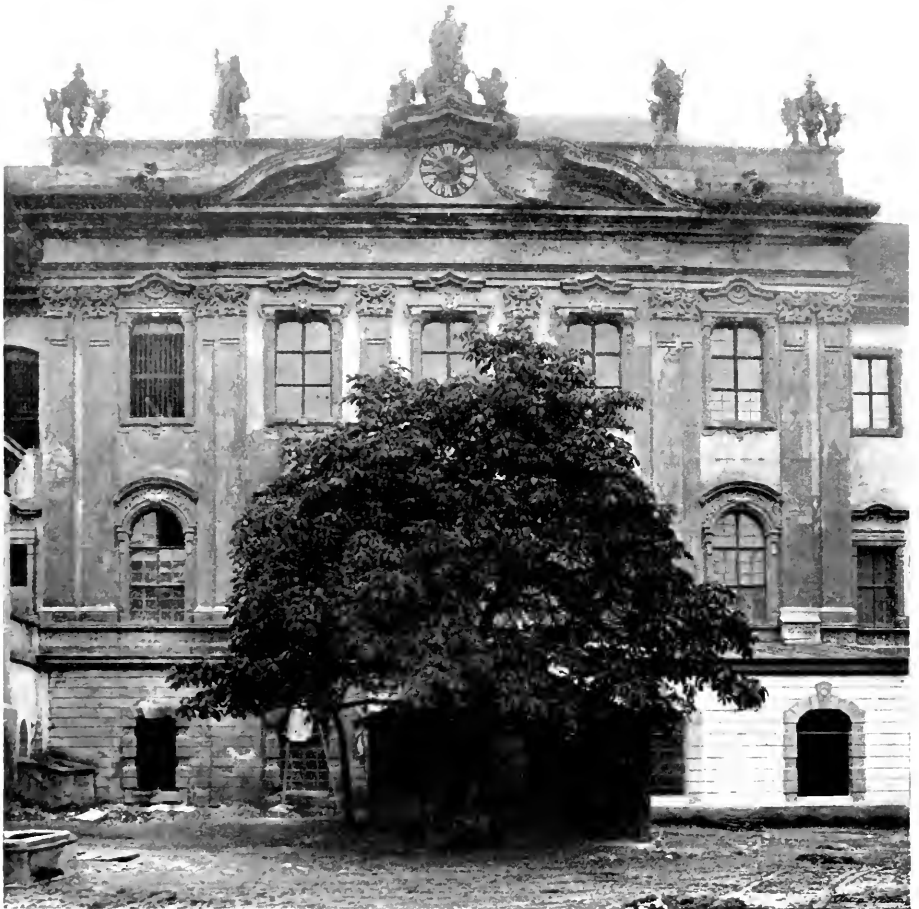
Obr. 81. Kladruby. Klášter. Průčelí nádvoří.
