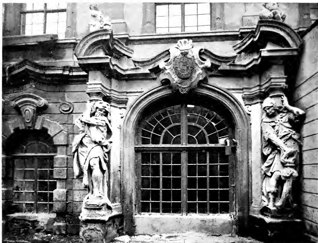
Obr. 83. Kladruby, Klášter, Portál v hlav. průčelí.
