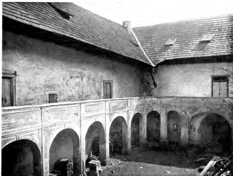
Obr. 85. Kopec. Zámek. Pohled do nádvoří.
