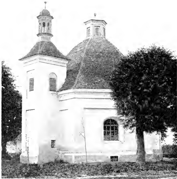
Obr. 36. Hracholusky, Kaple sv. Diviše. Pohled od jihu.
