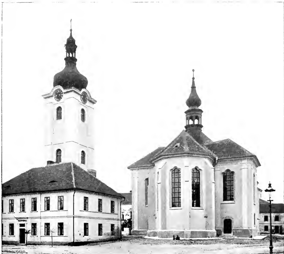
Obr. 6. Dobřany. Kostel sv. Mikuláše. Pohled od východu.
