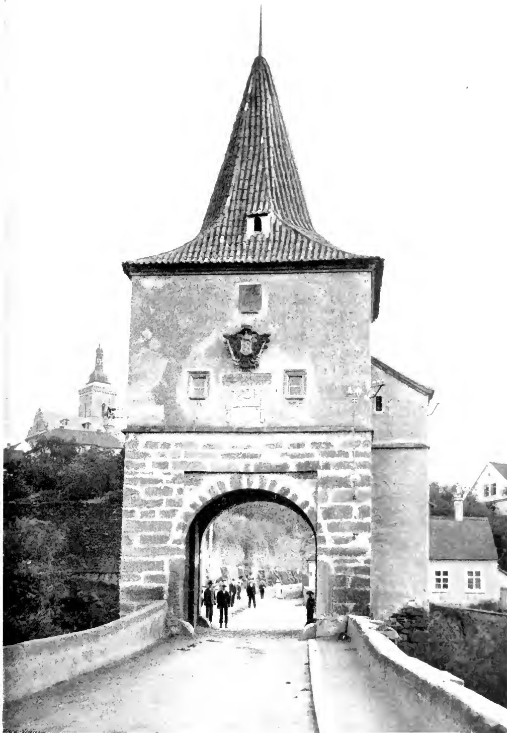
Obr. 129. Strážov. Věž na mostě. Pohled zevnější.
