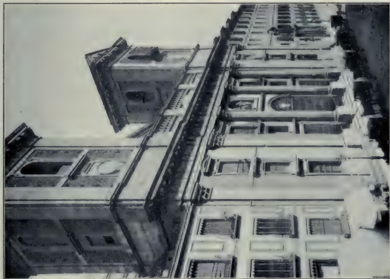
a. Madrid. S. Pedro el Real. Fassade. (Phot. J. Sacoffe.)
