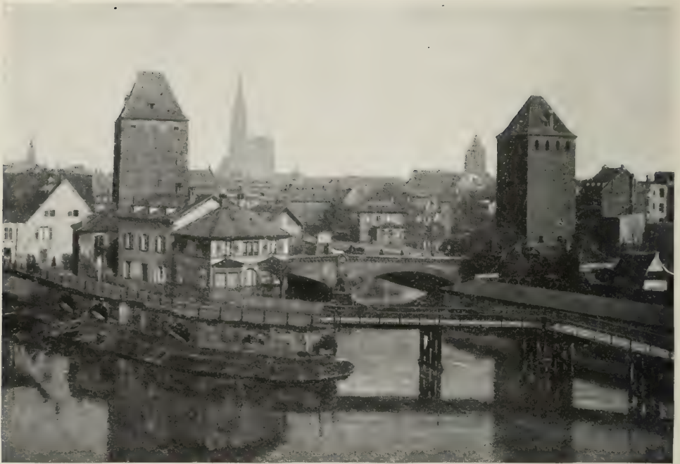
LES PONTS COUVERTS. (Cliché LL.)
