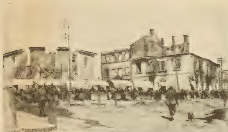
Platz im südlichen Stadtviertel nach dem Brande.
