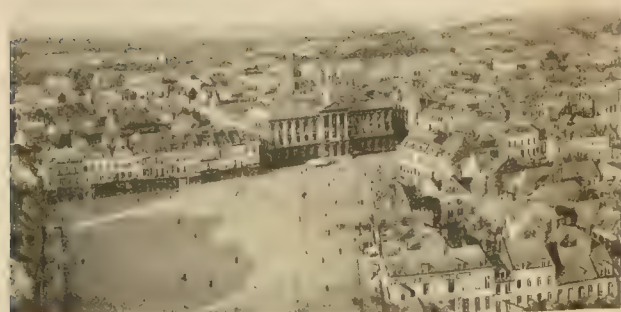
Großer Platz vor dem Stadthaus 1918. Noch völlig unberührt.
