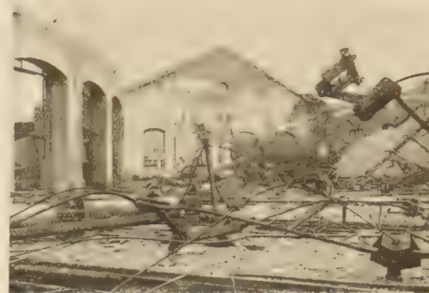
Der von den Engländern auf dem rumänischen Rückzug 1917 zerstörte Lokomotiv-Schuppen bei Faurey in Rumänien.
