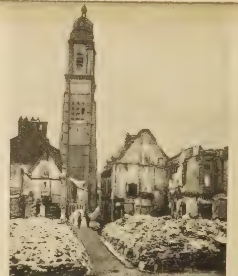
Der Belfroi und die St. Martinsstraße nach der englischen Zerstörung.
