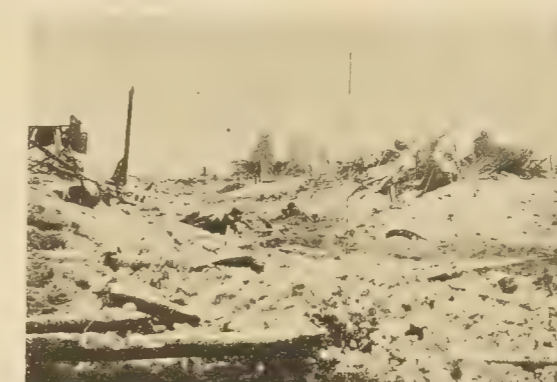
Das zerstörte Le Transloy.
