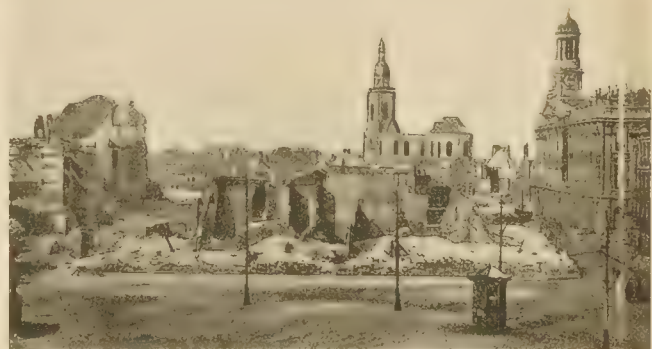
Dasselbe nach der Beschießung. Bild von der Seite aufgenommen. Der sichtbare zerstörte Häuserblock ist auf nebenstehendem Bilde des unzerstörten Marktplatzes rechts erkennbar.
