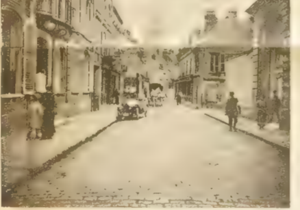
Die unzerstörte Rue de Paris in Noyon im Jahre 1914/15.
