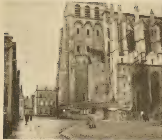
Seitenansicht der Kathedrale. Das Gerüst auf der rechten Seite des Bildes zeigt die Bemühungen, Witterungsschäden an dem kostbaren Bauwerke auszubessern.
