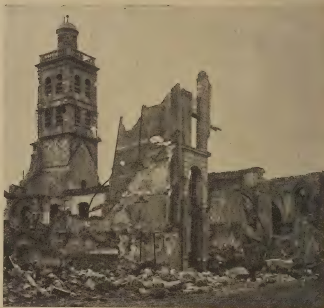
Der Börsenturm nach der Beschießung
