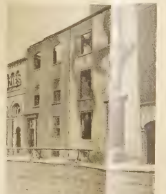
Das durch Niederbrennen zerstörte Transportarbeiterhaus in Cork.
