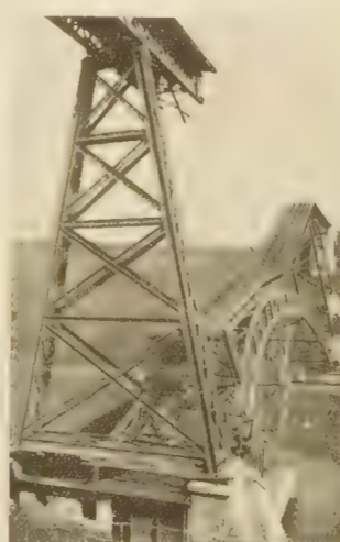
Von den Franzosen 1914 auf ihren Rückzügen gesprengte Eisenbahnbrücke bei Bouillonville.
