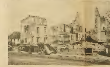
Das zerstörte Sonnenheim i. Elsaß.
