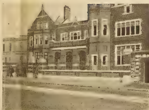
Die durch Feuer zerstörte Carnegie-Bibliothek.
