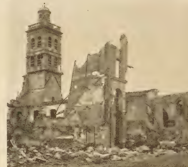
Der Börsenturm nach der Beschießung
