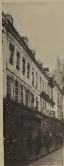
Der Nebeneingang völlig unzerstört.
