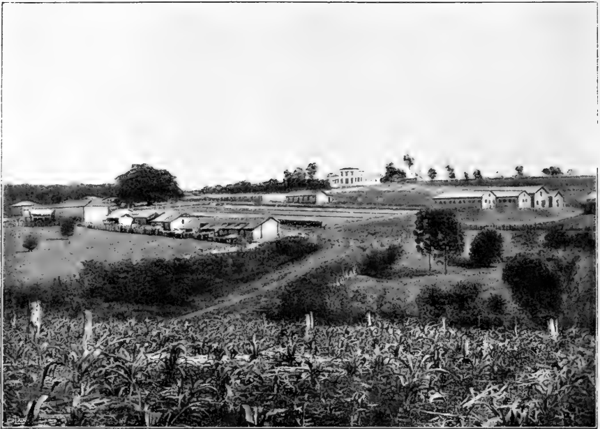
Fig. 6. Fazenda Santa Albertina, sedd från NW. I fonden den hvita huvudbyggnaden, uppförd af tegel i italiensk villastil. Närmast framför den till vänster nya terreiros, belagda med cement. Vid sidan af dessa till höger en arbetarbostad och framför denna äldre terreiros med golf af stampad röd jord. De fyra husen på bildens högra sida äro ladugården. Det stora ensamma trädet till vänster är en » figueira », d. v. s. ett slags fikonträd, som utvecklats från en färsk stock, hvilken för knappa femtio år sedan här nedsattes i jorden för att tjäna såsom grindstolpe. Det högsta huset i längan framför figueiran är tröskhuset. De öfriga äro smedja, snickarverkstad o. s. v. samt arbetarebostäder. De två höga träden på betesmarken framför ladugården äro Araucaria brasiliana Lamb. I förgrunden en kaffeplantering, där de unga kaffeplantorna döljas af den uppväxande majsen. Talrika stubbar finnas kvar efter den borthuggna skogen.
