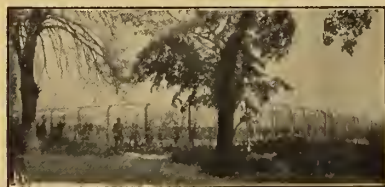
Abb. 2. Drahtzaun aus gekrümmten Drtan-Betonpfoften.
