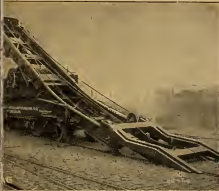
Abb. 1. Der Schleppwagen ist heruntergelassen, der zu ent- leeren Wagen wird durch die Seilwinde herangeholt.
