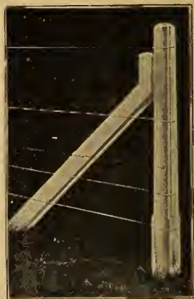
Abb. 3. Drahtzaun aus Drtan-Betonpfoften.
