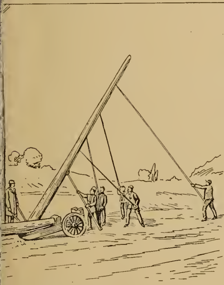
Früher de im Leitungsbau jede Stange mühsam durch viele Arbeiter ausgerichtet, wobei oft Unfälle vorkamen.
