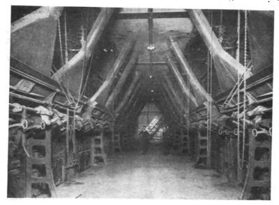
Fig. 8. FOILER ROOM, SHOWING STOKERS AND COAL CHUTES.
