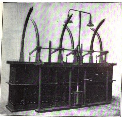
FIG. 7—60,000-VOLT LARGE OIL CIRCUIT-BREAKER.
