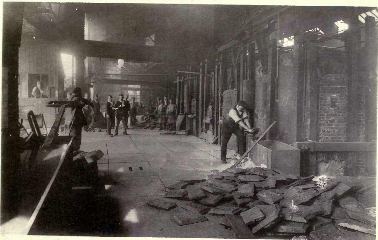
SIEMENS-MARTIN FURNACES, 1 45 TON., 2 30 TON..
