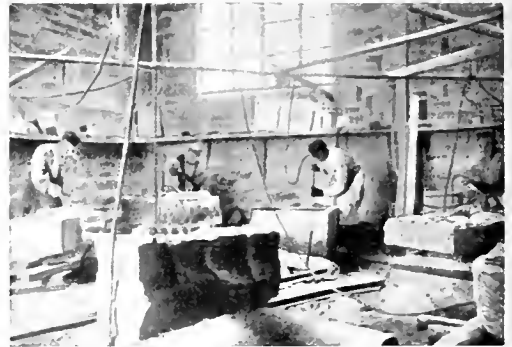
Kuva 13. Graniittikoristeiden hakkaaminen puristetulla ilmalla käyville talleilla.
