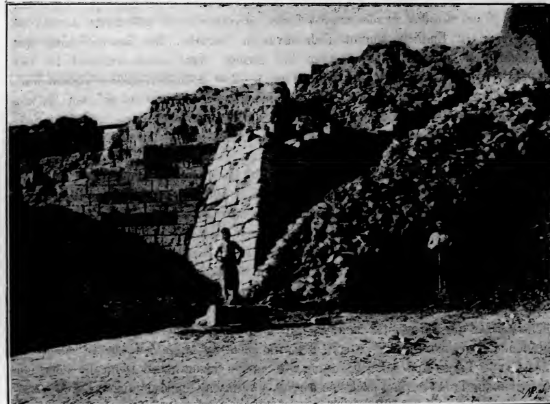
Nordecke des grossen Thurms. Links römisches Quaderfundament mit Steinmetzzeichen.
