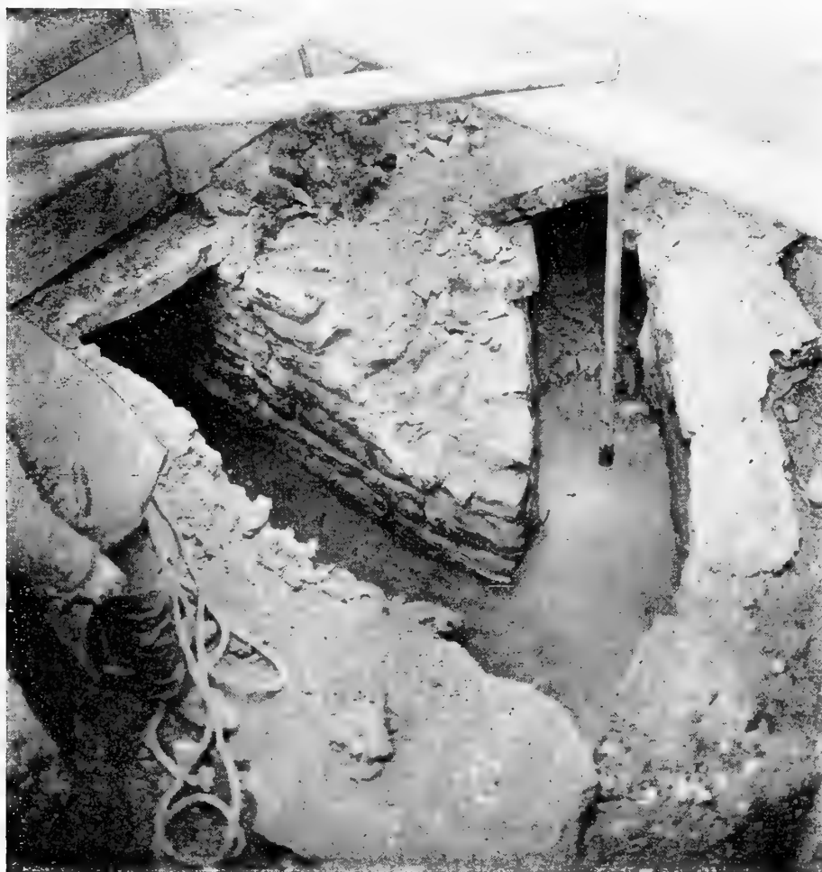
Фиг. 2. Видъ на дно выемки, углубленной въ мѣстѣ нахождения колодца „а“. Съ лѣвой стороны фотографіи виденъ каналъ, который идетъ отъ каптажнаго колодца, съ правой стороны, тамъ, гдѣ находится труба, виденъ заброшенный каналъ, найденный при раскопкахъ.
