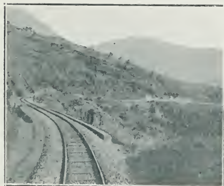
La voie ferrée de Tourane à Hué (Annam) près du col des Nuages.
