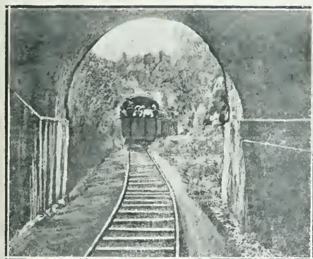
Ile de Ké-Bao: Un des tunnels de la voie ferrée.
