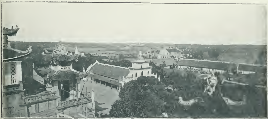
Mission catholique de Phat-Diêm : Vue d'ensemble prise du clocher de la Cathédrale.
