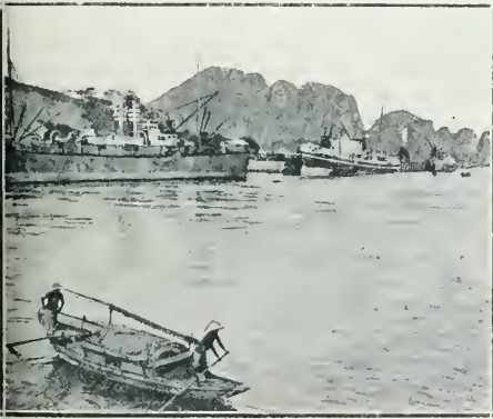
Baie d'Along : Quais de la Société des Charbonnages du Tonkin.
