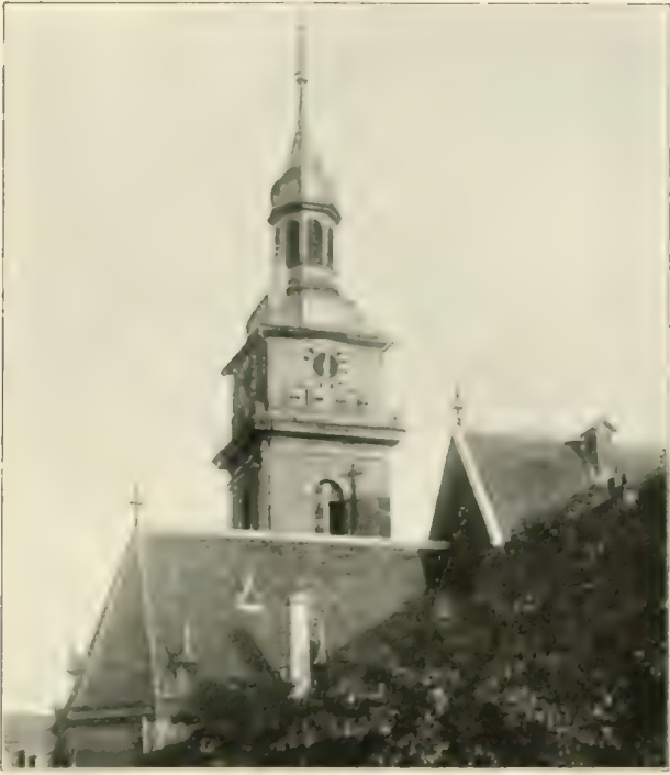
Stuttgart. Turm der Hospitalkirche. 1738
