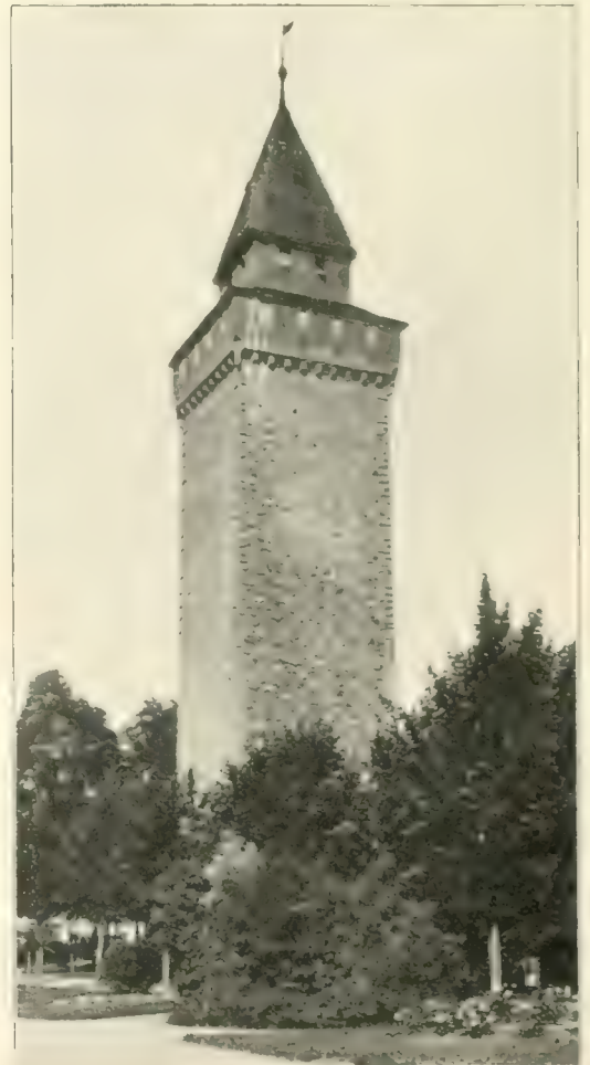
Phot. H. Hartlieb-Ravensburg Ravensburg. Torturm
