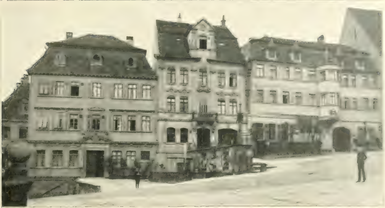
Haus, Hauptgasse und Hofplatz in Hildesheim
