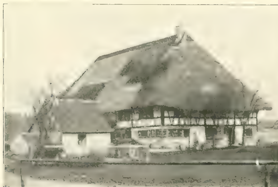
Oberessendorf. Bauernhaus mit Strohdach
