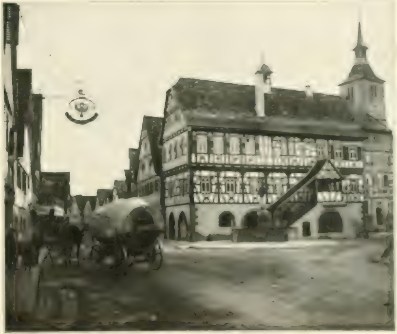
Strasse in Schwyz bei Luzern
