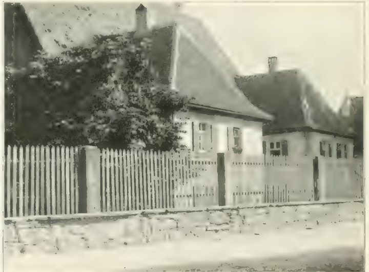
Crailsheim. Teil des Spitals
