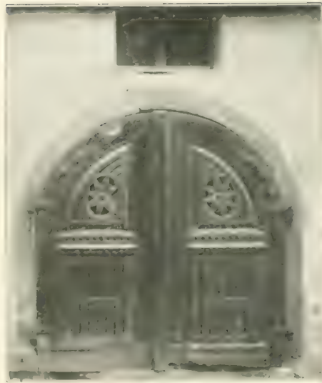
Aus Möckmühl. Kellereingang
