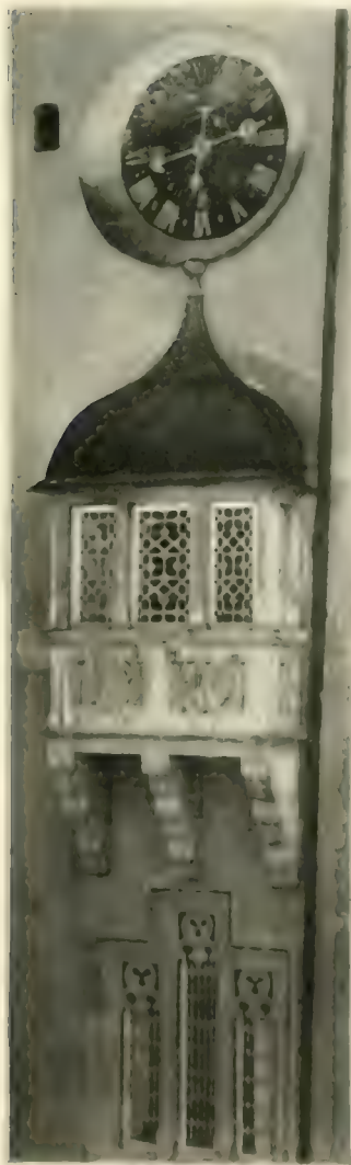
Ravensburg. Fassade des Blauturms
