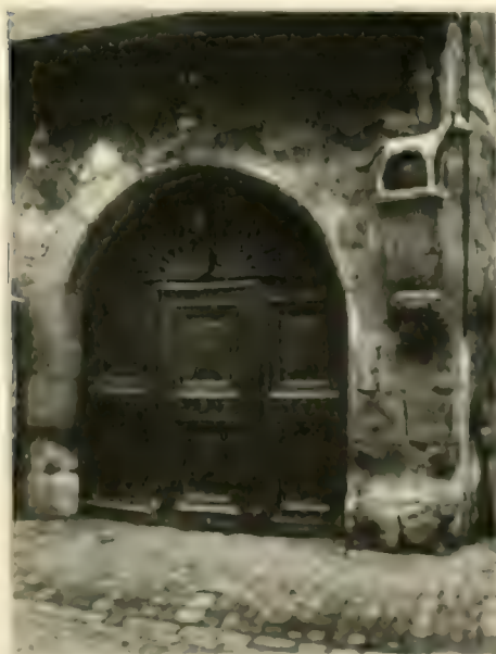
Erdingen. Pforte aus Holz aus Wall
