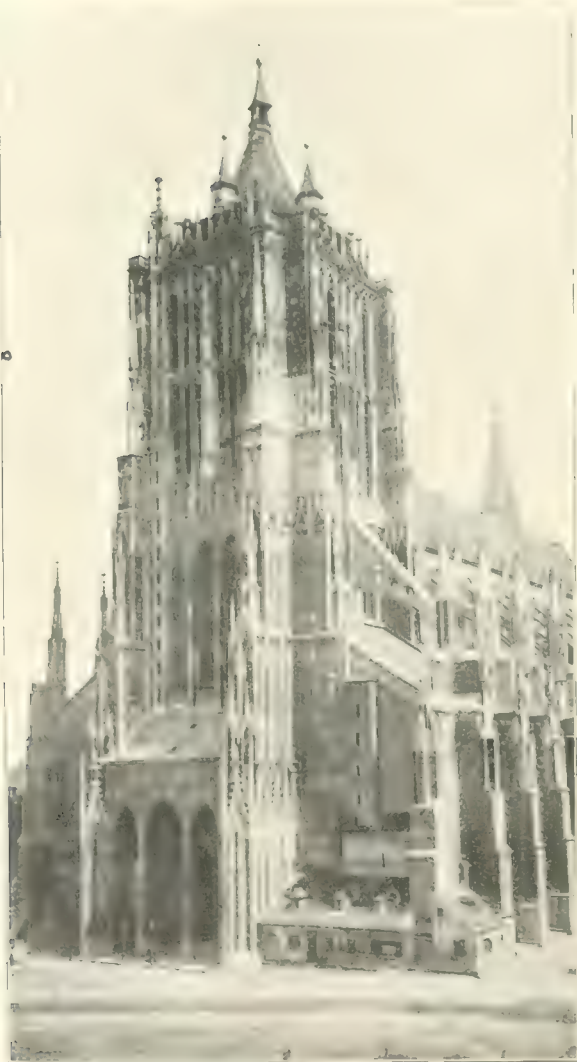
Ulm. Münsterturm vor dem Ausbau
