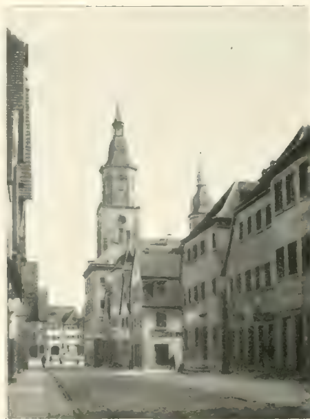
Crailsheim. Hauptstraße m. d. Stadtturm von 1717
