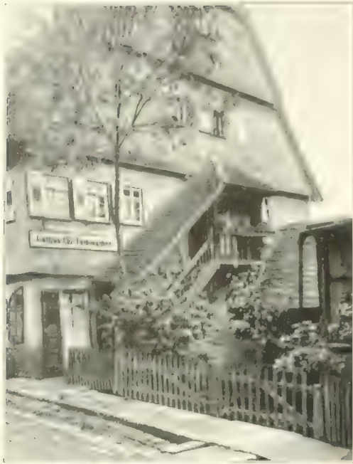
Lauffen a. N. Wohnhaus mit Treppenaufgang
