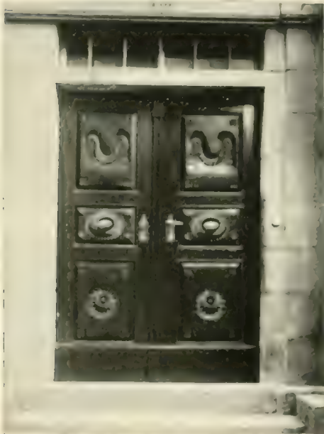
Möckmühl. Hauspforte. Anfang des 19. Jahrhunderts
