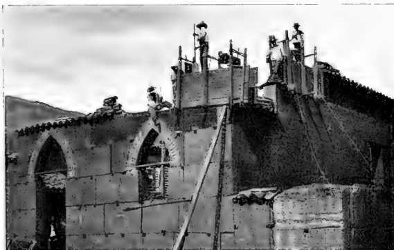
Construction d'une maison en terre battue.
