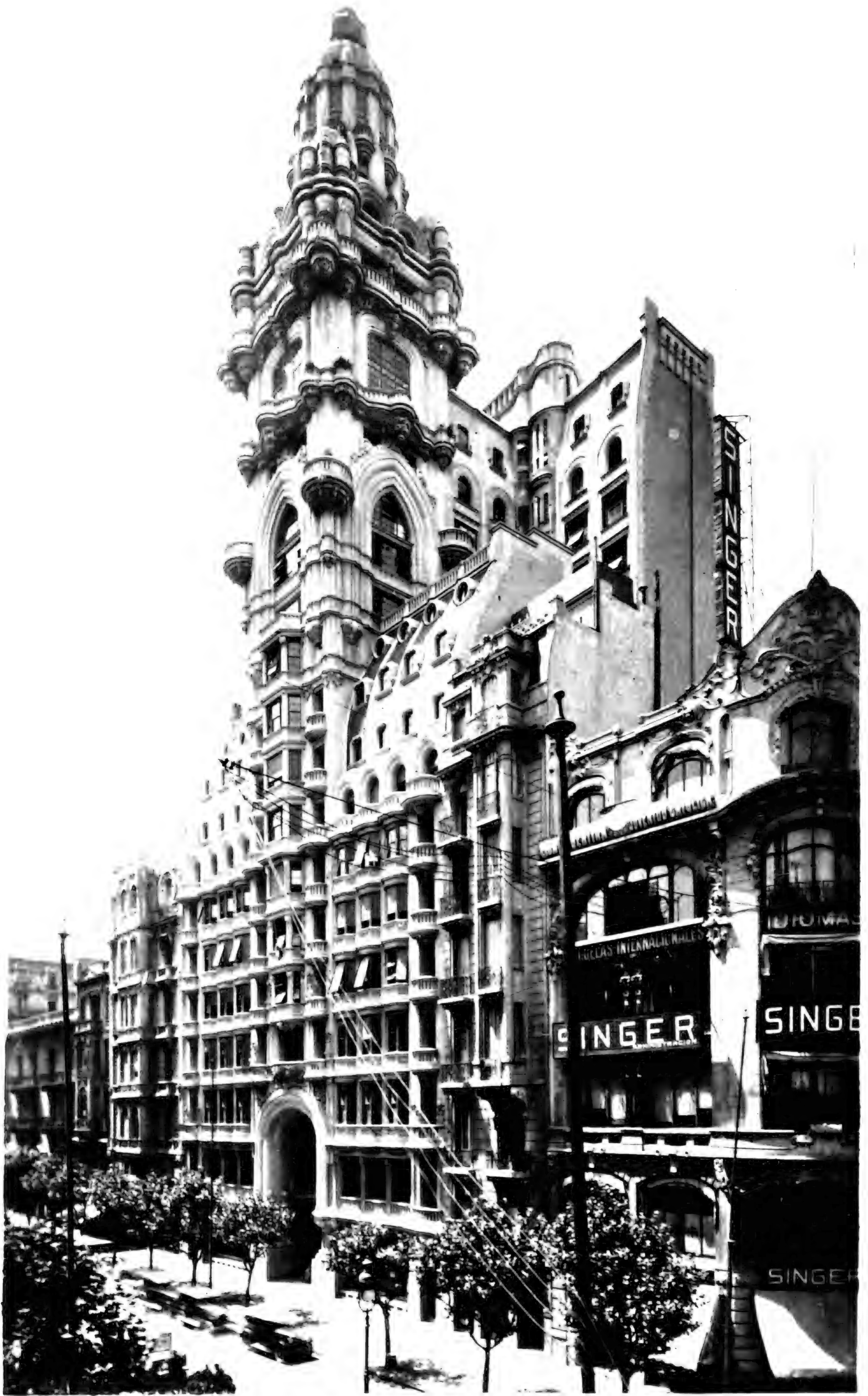
BUENOS AIRES - EDIFICIO BAROLO
