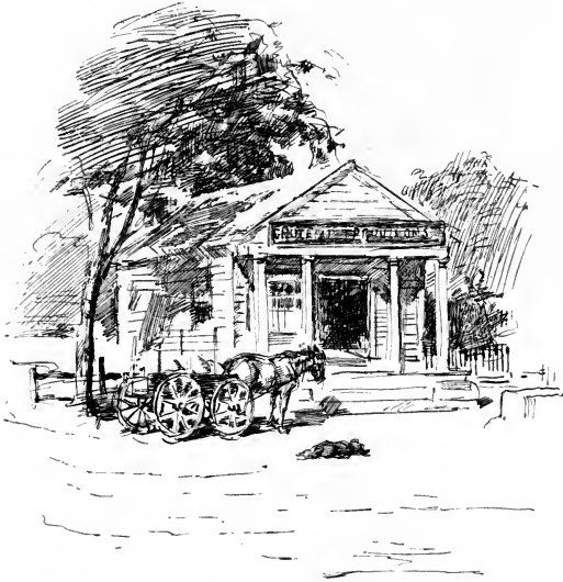
The Grecian Portico
