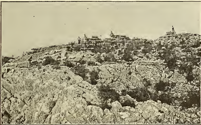
Fig. 5. Festungsmauer und Thürme auf der „Gradina“ bei Ošanić.
