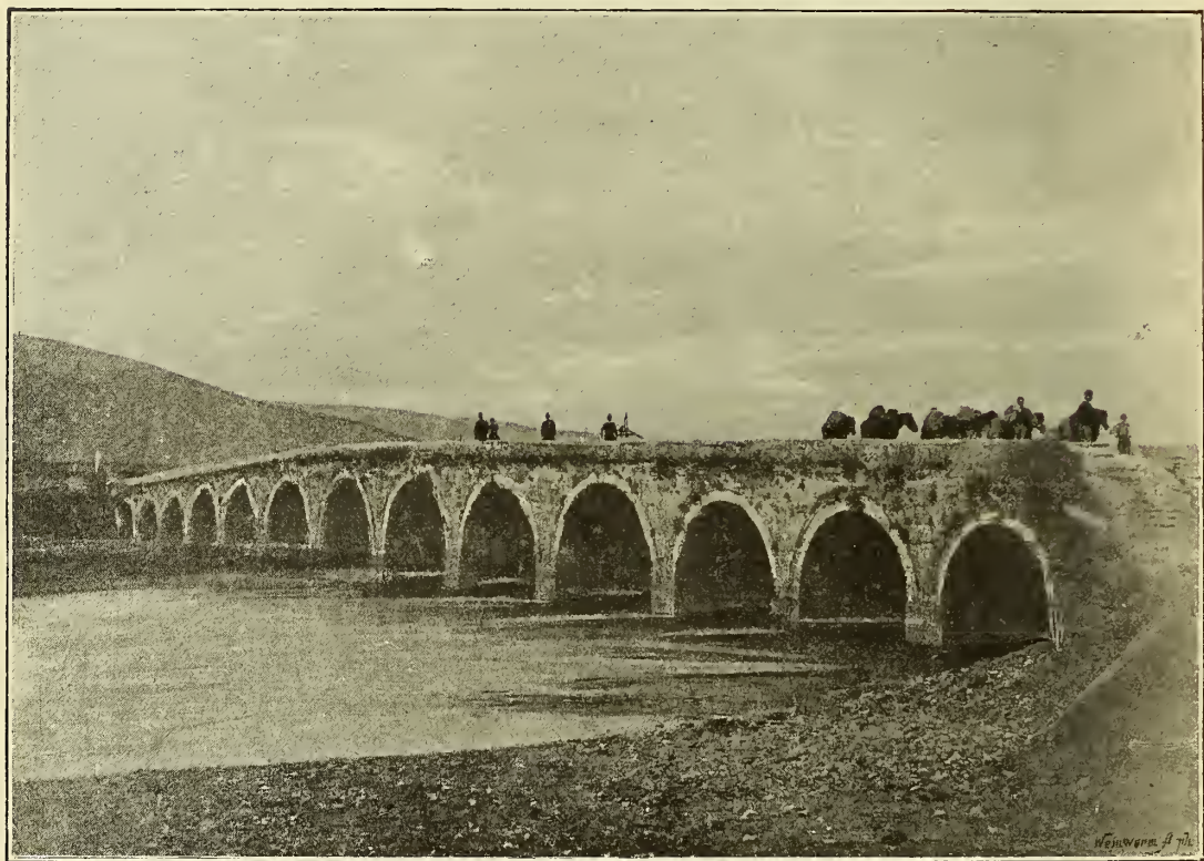
Fig. 7. Alte Steinbrücke über die Buna.
