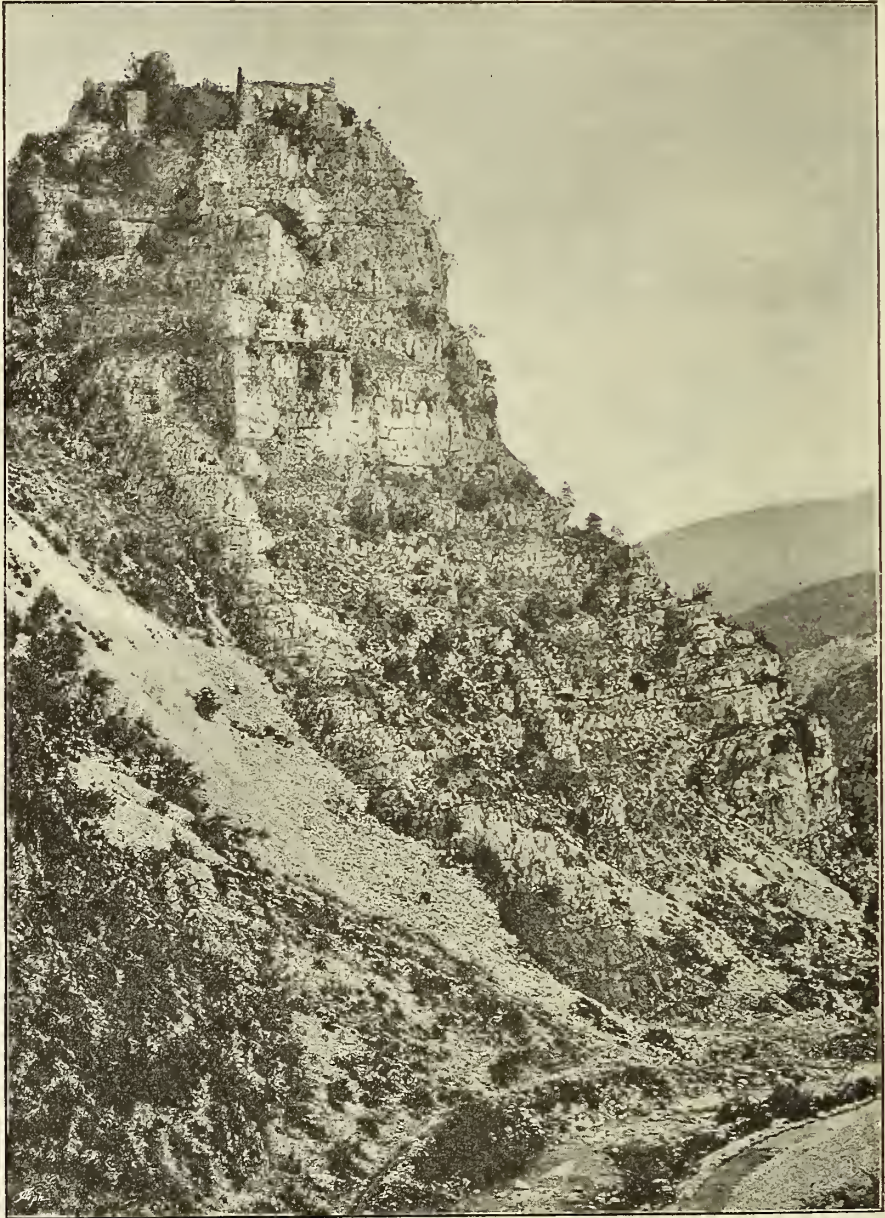
Fig. 27. Ansicht der Burgruine Visuograd von Nordosten.
