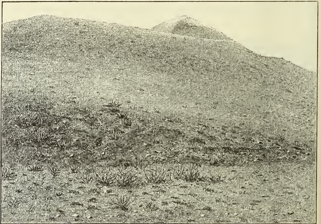
Fig. 8. Ansicht der Gradina kod gaja bei Županjac von Nordwesten.
