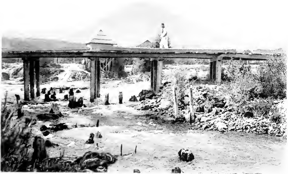
a) Ansicht von Pfählen in der Una bei Ripač.
