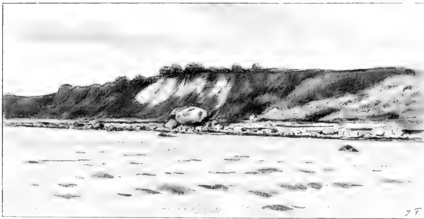
Fig. 180. Alsen: Kliff vor Lysabbelholz mit dem riesigen erratischen Block davor.
