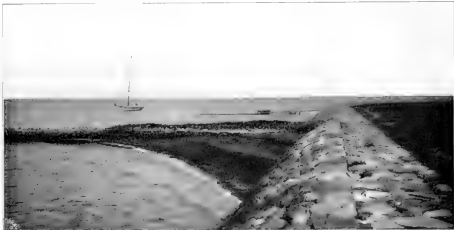
Fig. 28. Rechts der Steindeich von Oland, links der aus Buschpackung bestehende, nach Langeneß hinüberführende Damm. Im Winkel beider hat sich schon etwas noch vegetationsloses Land angeschlickt.
