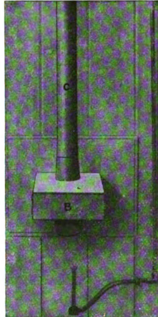
Fig. 12. — Abzug außerhalb des Arbeitsraums.
