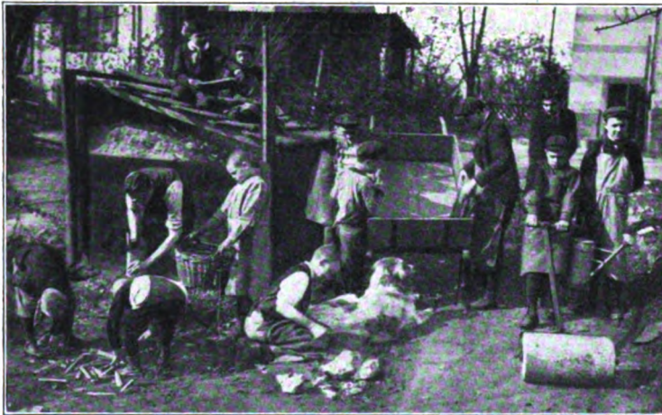
Hofgeschäfte: Abbruch der Aschenhütte.
