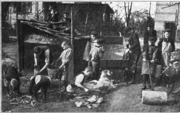
Hofgeschäfte: Abbruch der Aschenhütte.
