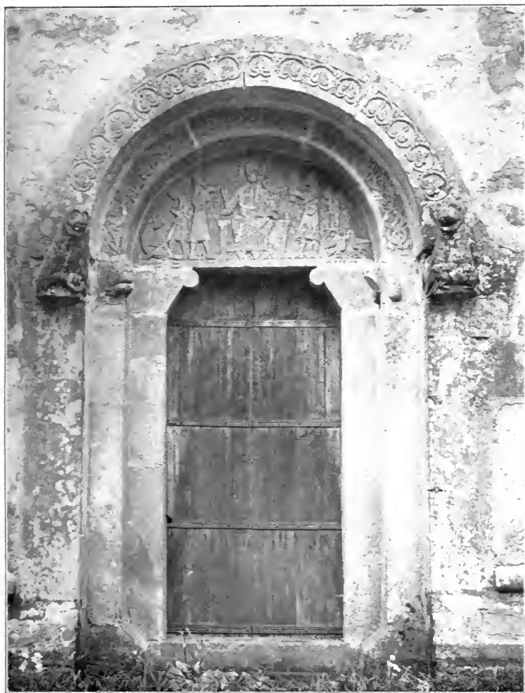
Abb. 11. Portal zu Habtingbo.
